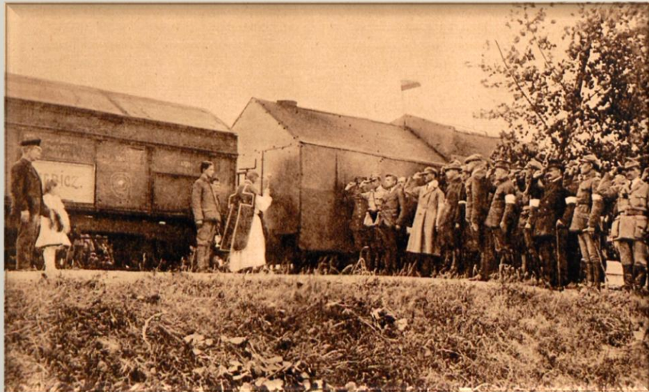
msza św. przy pociągu pancernym
