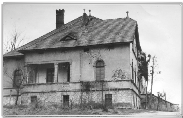
ZNISZCZONY PAŁAC REITZENSTEINÓW, STOPNIOWO REMONTOWANY DO 1948 ROKU
