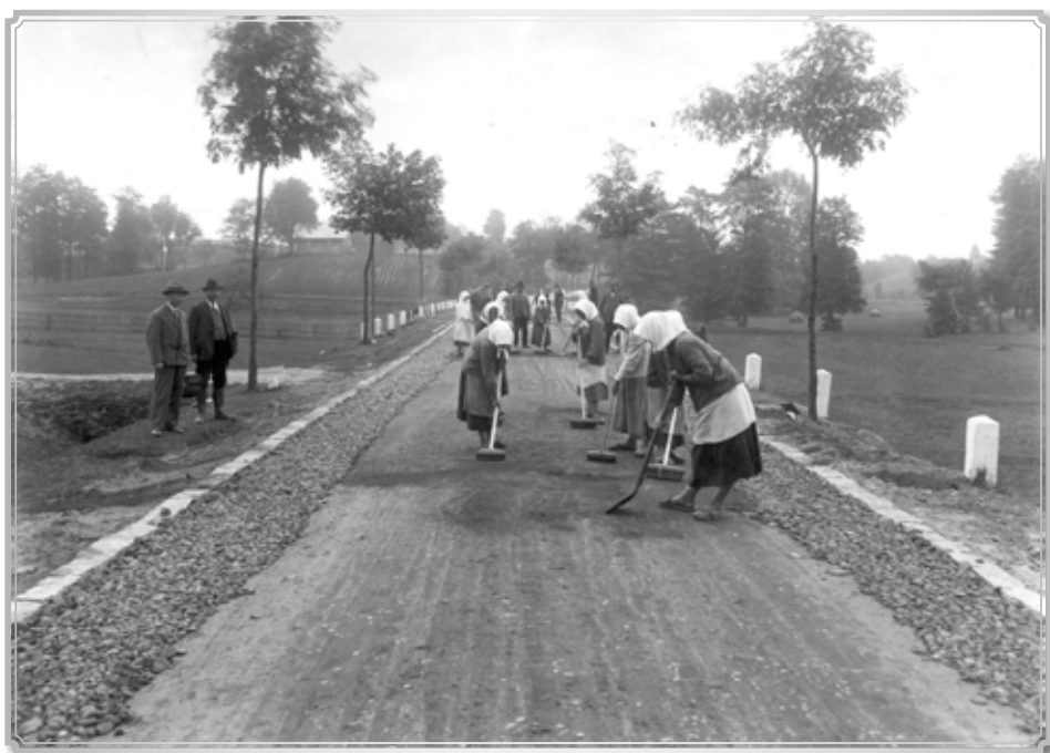
BUDOWA DROGI PAWŁOWICE – JASTRZĘBIE-ZDRÓJ, 1928 ROK
