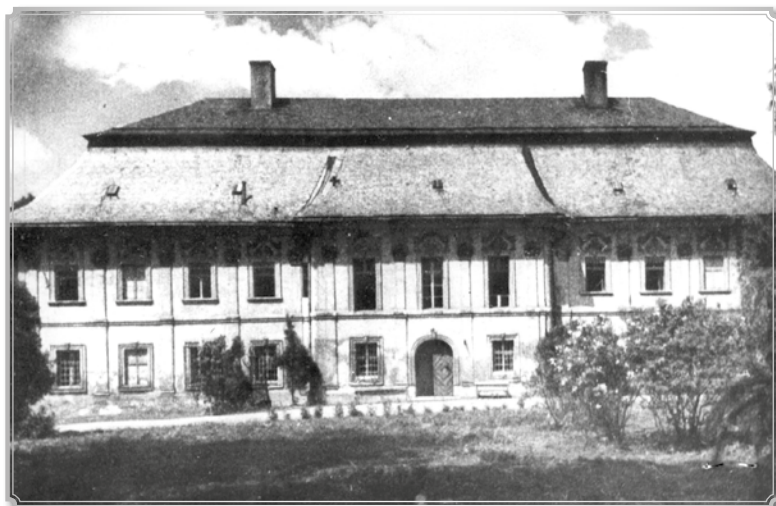
PAŁAC REITZENSTEINÓW, ELEWACJA TYLNA, OGRODOWA
