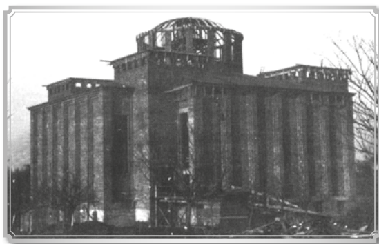
BUDOWA NOWEGO KOŚCIOŁA KATOLICKIEGO, FOTOGRAFIA Z OK. 1958 ROKU
