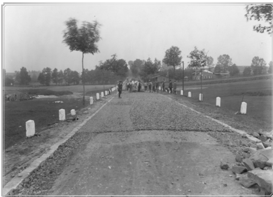
BUDOWA DROGI PAWŁOWICE – JASTRZĘBIE-ZDRÓJ, 1928 ROK
