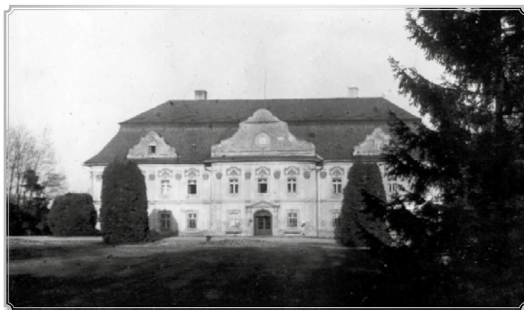
PAŁAC REITZENSTEINÓW, ELEWACJA FRONTOWA, ZACHODNIA (OD STRONY UL. ZJEDNOCZENIA)
