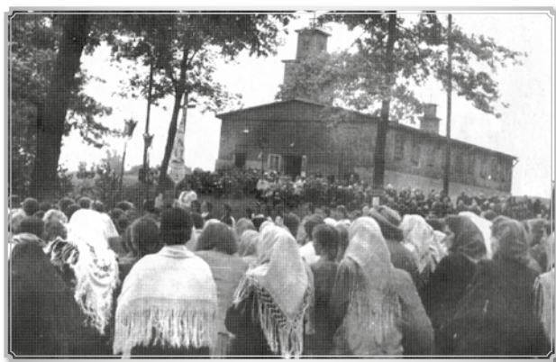
TYMCZASOWY KOŚCIÓŁ-BARAK POŚWIĘCONY 5 SIERPNIA 1945 ROKU, SŁUŻĄCY MIESZKAŃCOM WARSZOWIC DO CZASU WYBUDOWANIA NOWEJ ŚWIĄTYNI W 1959 ROKU
