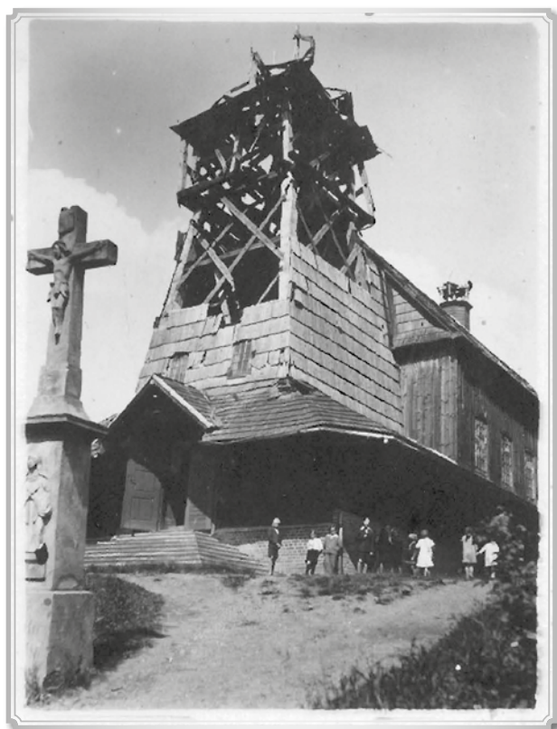
ZABYTKOWY KOŚCIÓŁ ZNISZCZONY W 65% W CZASIE DZIAŁAŃ WOJENNYCH WIOSNĄ 1945 ROKU, WIEŻĘ CZĘŚCIOWO ODBUDOWANO W 1947
