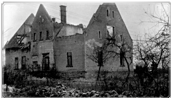
ZNISZCZONA PO POŻARZE PLEBANIA PRZY KOŚCIELE EWANGELICKIM (ZBUDOWANA W 1894 ROKU)
