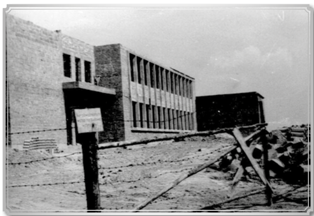
Nowa szkoła w budowie, strona frontowa, fotografia z sierpnia 1963 roku
