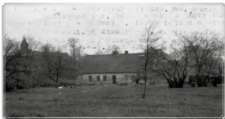
BUDYNEK ORGANISTÓWKI, MIARKÓWKI, FOTOGRAFIA Z POŁOWY LAT SZEŚĆDZIESIĄTYCH WIDOK OD STRONY POŁUDNIOWEJ, Z LEWEJ STRONY WIDOCZNA WIEŻA KOŚCIOŁA
