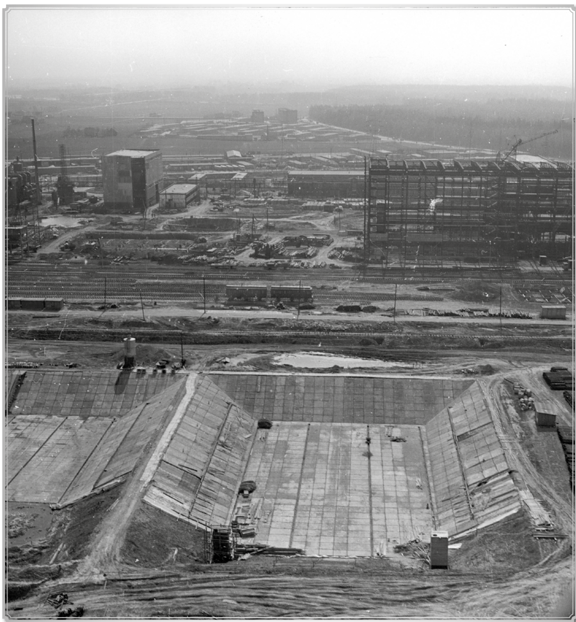
KOPALNIA WĘGLA KAMIENNEGO PNIÓWEK W BUDOWIE
