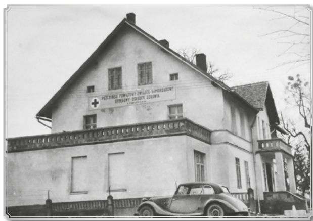
WILLA REITZENSTEINÓW, ELEWACJA ZACHODNIA, WIDOK OD STRONY UL. ZJEDNOCZENIA
