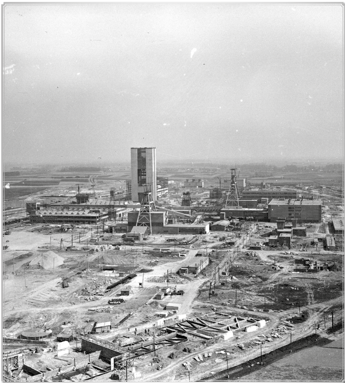
KOPALNIA WĘGLA KAMIENNEGO PNIÓWEK W BUDOWIE
