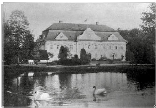
PAŁAC REITZENSTEINÓW, ELEWACJA FRONTOWA
