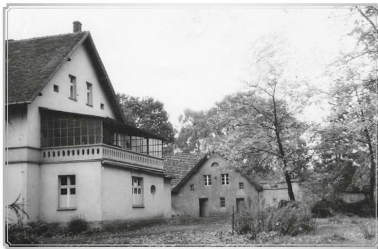
WILLA REITZENSTEINÓW OD STRONY POŁUDNIOWO-WSCHODNIEJ
