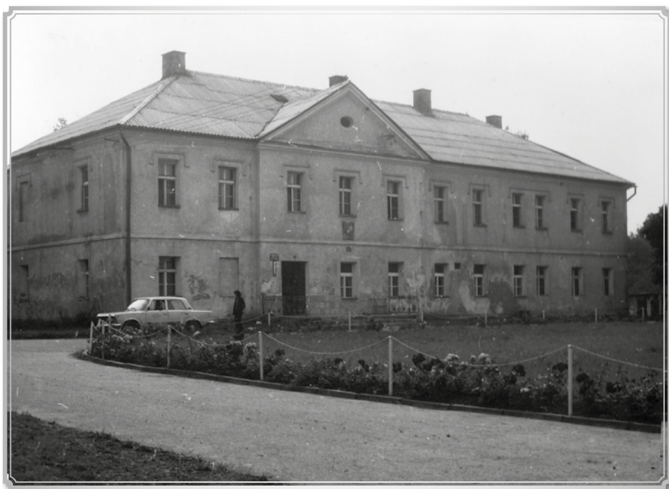
WIDOK NA DWÓR W JARZĄBKOWICACH OD STRONY ZABUDOWAŃ FOLWARKU, FOTOGRAFIA Z LAT SIEDEMDZIESIĄTYCH
