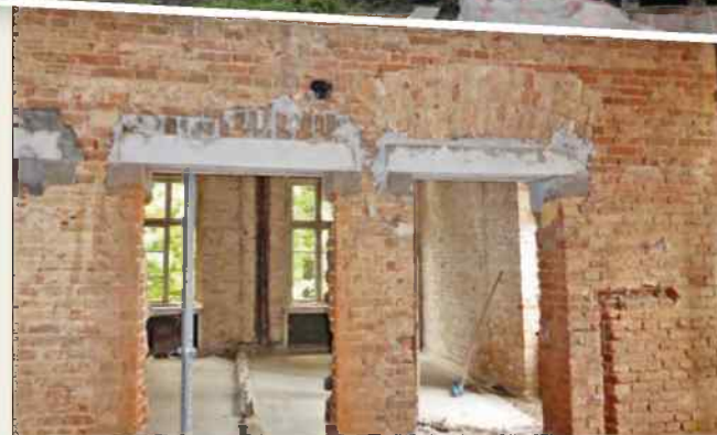
Sporo jest jeszcze do zrobienia, ale dzięki pozyskanej przez miasto dotacji pałac stanie się kolejną architektoniczną perłą w Żorach
