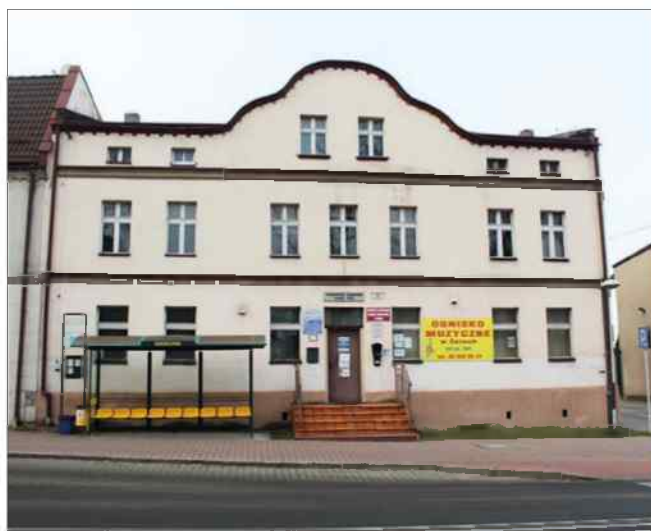
Na zdjęciu przeznaczona do remontu kamienica przy ul. Dworcowej
