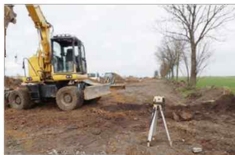
Przebudowa drogi powiatowej w Kornicach
