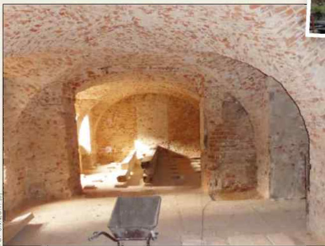
Wewnątrz budynku wykonano już sporo prac, m.in. skuto zostały tynki
