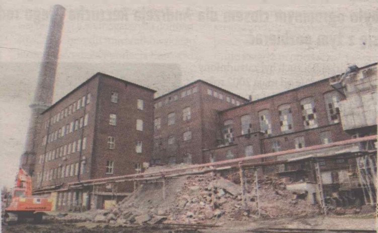
Tuż obok starej elektrociepłowni stanie nowa - budowa już się rozpoczęła.
