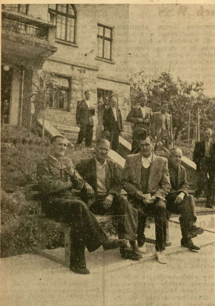
W prewentorium im. Wincentego Pszowskiego w Szczawnicy leczą się górnicy zagrożeni pylicą. Na zdjęciu górnicy kładące się przed gmachem prewentorium
