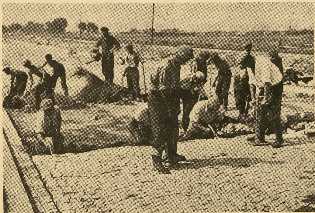
Szybko postępuje naprzód budowa odcinka Trasy Północ-Południe na Zeraniu. Na zdjęciu układanie nawierzchni. Foto AR
