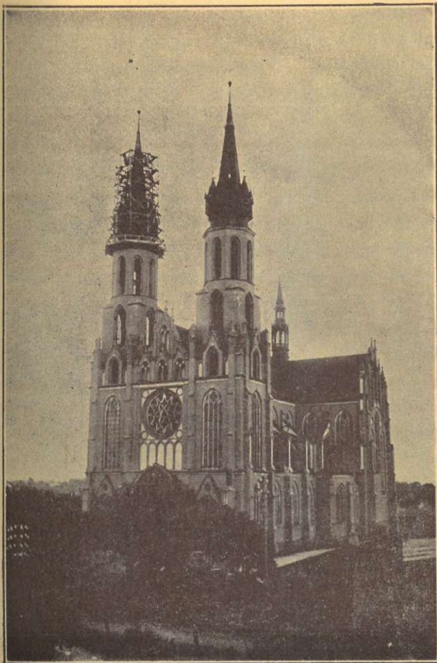
Kościół Opieki Najśw. Marji Panny w Radomiu. Rusztowanie na wieży podczas naprawiania dachu.
