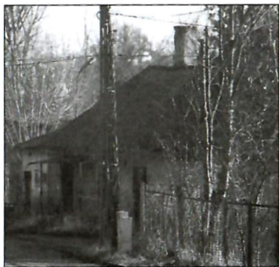
Ruiny garbarni (już nieistniejące).
