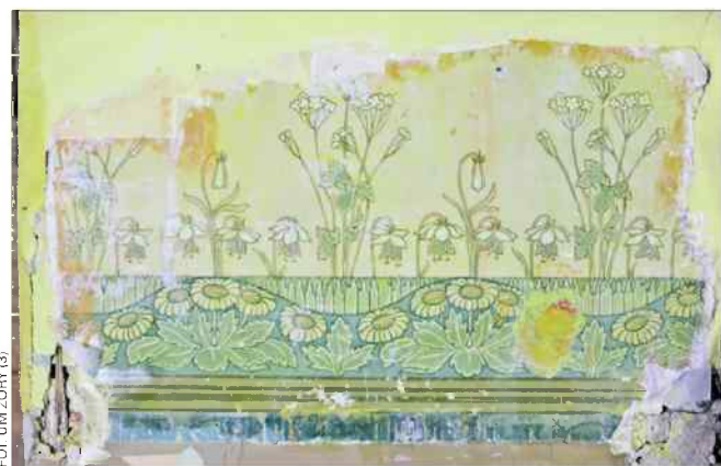
Na ścianach pałacu podczas remontu odkryto dawne polichromie
