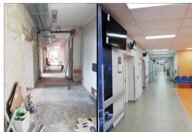
Jeden z korytarzy w czasie remontu oraz po jego zakończeniu
