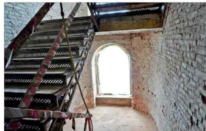
Wykonawcy i urzędnikom zależy na odwzorowaniu m.in. balustrady, ale do tego potrzebne są stare zdjęcia
