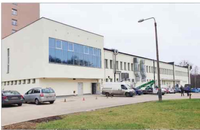
Budynek kuchni po remoncie
