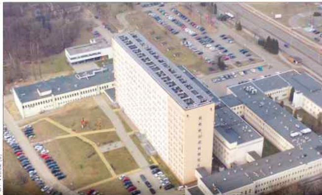
W ramach projektu na instalację kogeneracji, na dachu szpitala zabudowano kolektory słoneczne
