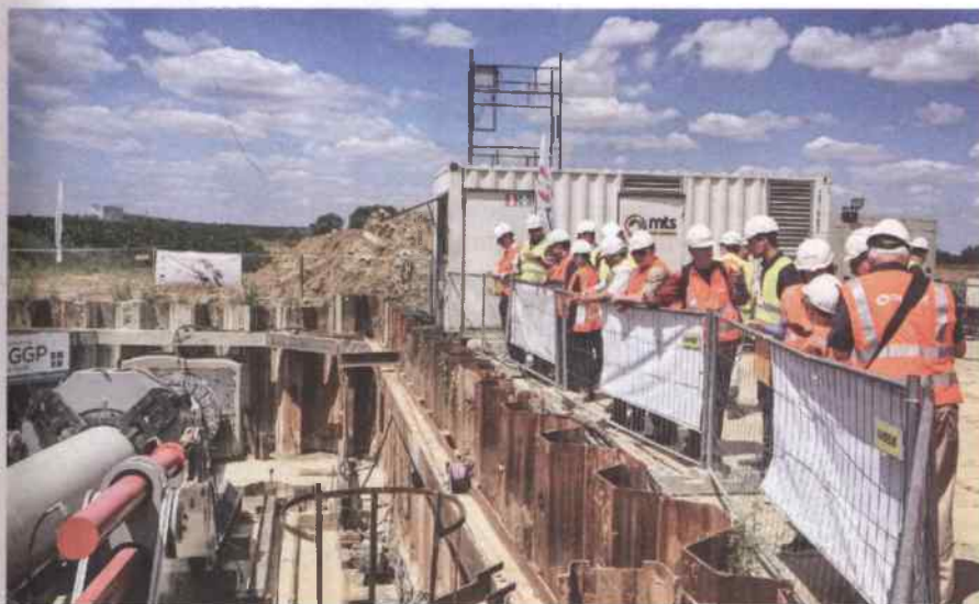
W Kątach Op. zaprezentowano prace związane z budową gazociągu, przebiegającego również przez teren gminy Gogolin
