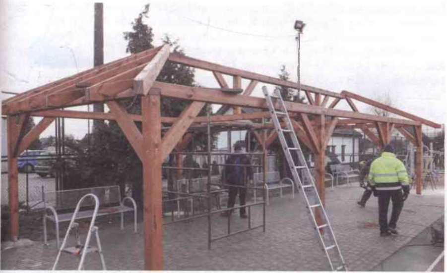
Budowa altany w Malni została częściowo sfinansowana z funduszu sołeckiego
