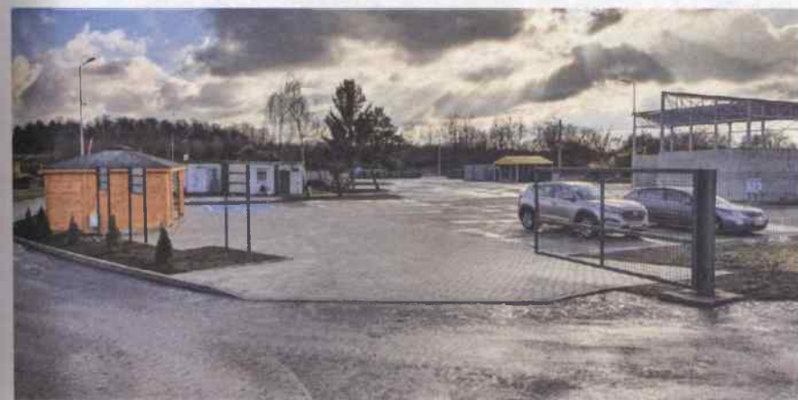
Punkt Selektywnej Zbiórki Odpadów po modernizacji
