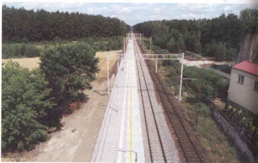
W ramach zadania wybudowano nowy peron w Górażdżach
