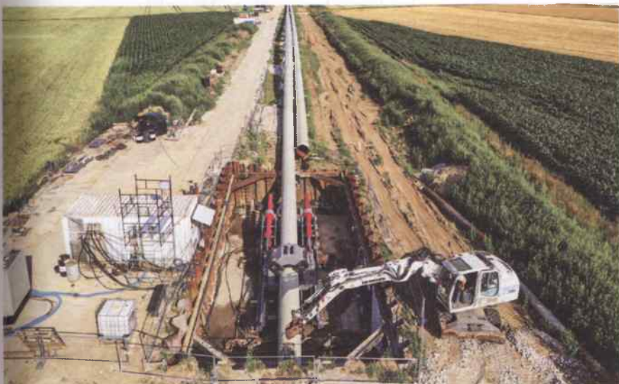
W 2019 prężnie postępowały prace na budowie gazociągu
