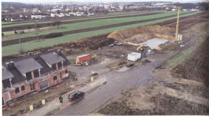
Prace na Osiedlu Dębowym ruszyły pełną parą
