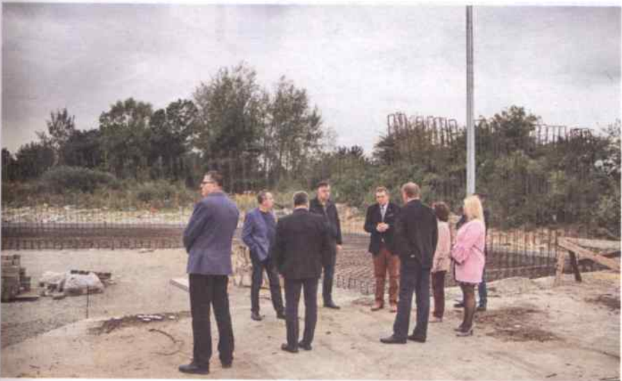
Wizytacja budowy nowego Punktu Selektywnej Zbiórki Odpadów
