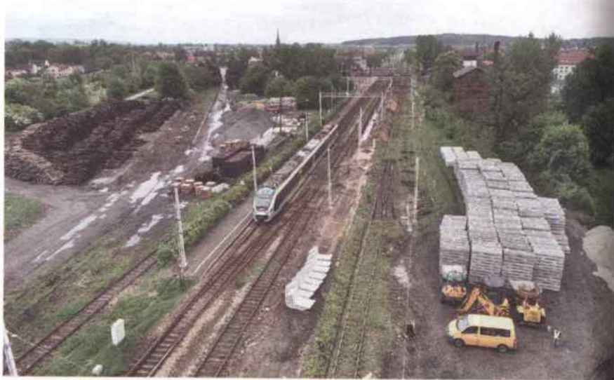
Prace na linii kolejowej E30 obejmowały także teren gminy Gogolin
