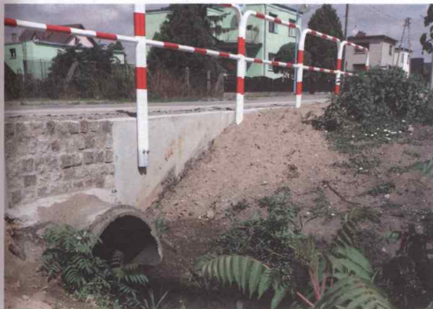
W ramach zadania rów zostanie poszerzony i zabezpieczony przed wylewaniem
