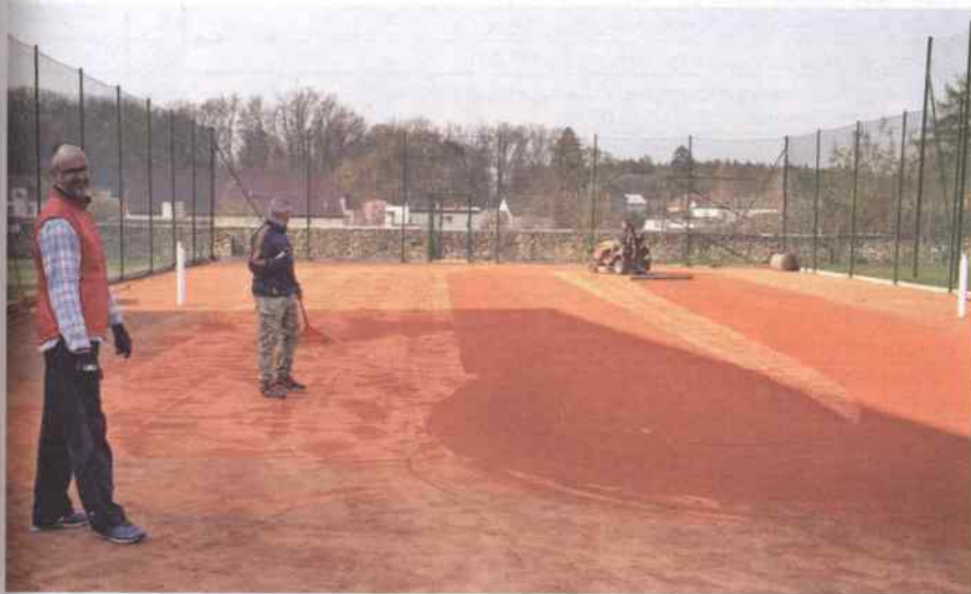
Prace na kortcie w Kamieniu Śląskim
