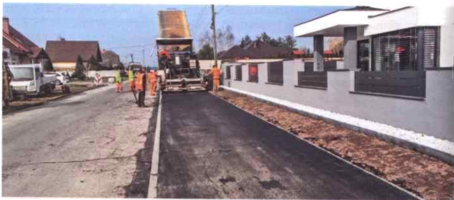
Budowa ścieżki pieszo – rowerowej przy ul. Sosnowej rozpoczęła się w 2021 roku
