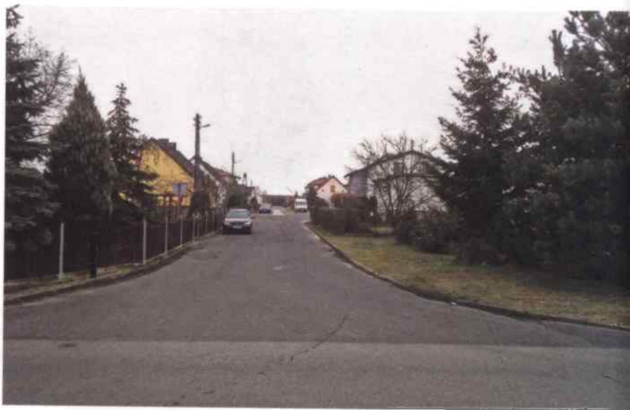
Ulica Przyjaźni w Gogolinie przed przebudową
