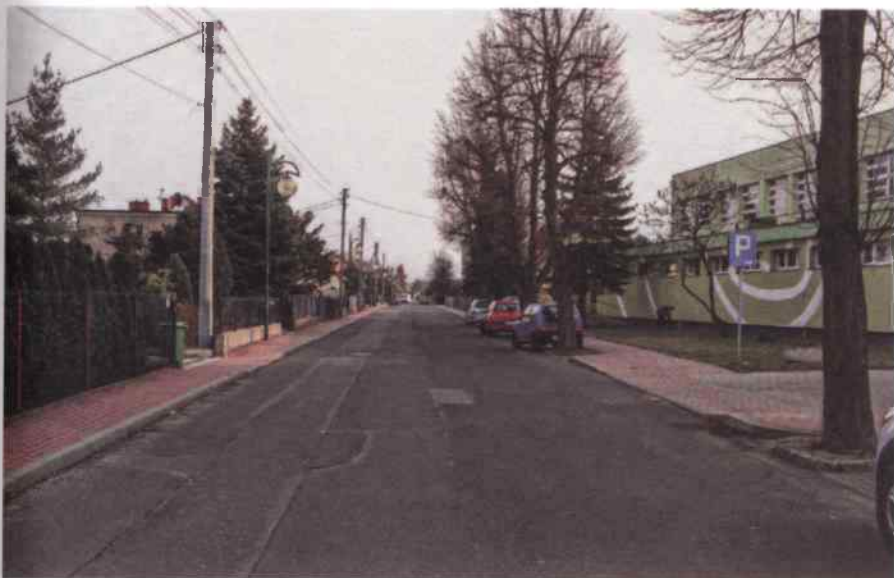
Ulica Wyzwolenia przed przebudową
