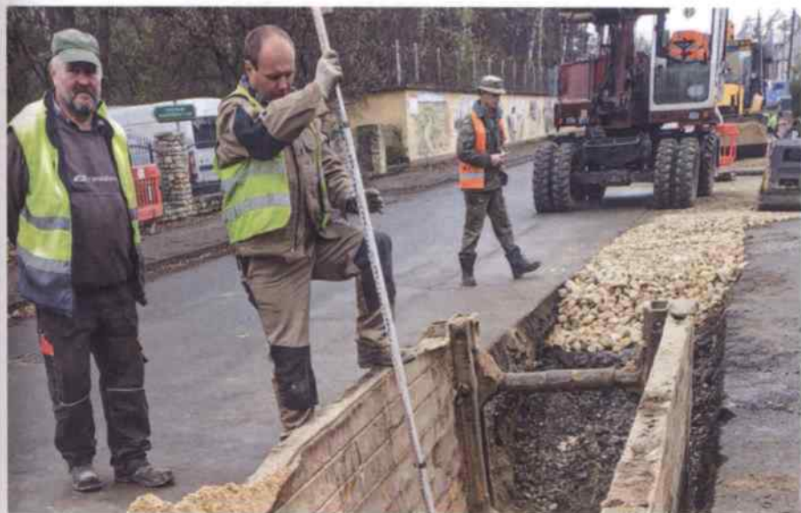
Modernizacja kanalizacji w Górażdżach
