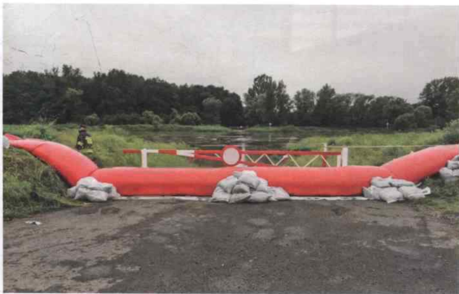
Zabezpieczenie zjazdu do rzeki Odra
