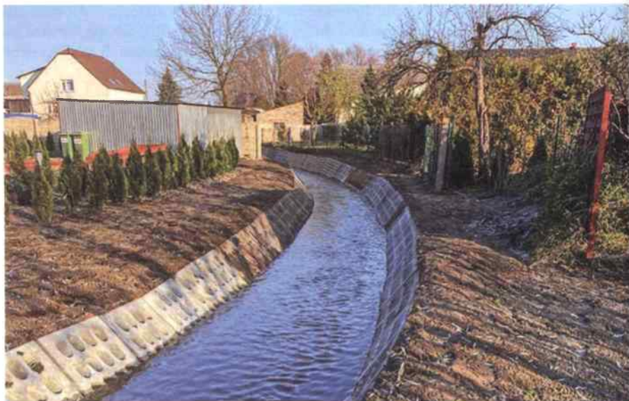
Dno i skarpy cieku zostały zabezpieczone płytami
