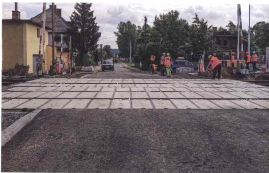
Przejazd kolejowy w miejscowości Góraždze po remoncie
