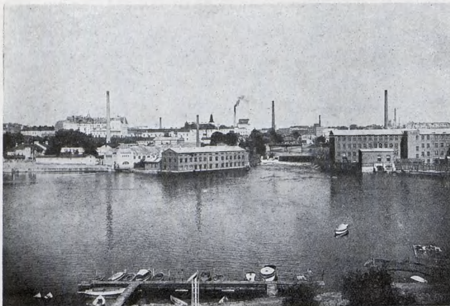
Kompleks budynków fabryk papierniczych w Tampere.
