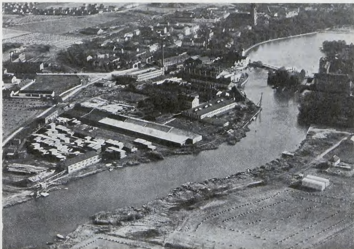
Eskilstuna. — Fabryki przemysłu metalowego.
