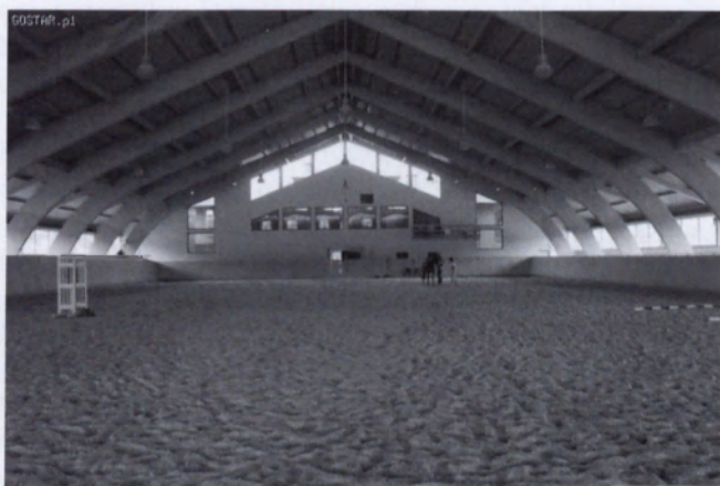
Kryta ujeżdżalnia umożliwia użytkowanie koni niezależnie od warunków klimatycznych (www.gostar.pl)
