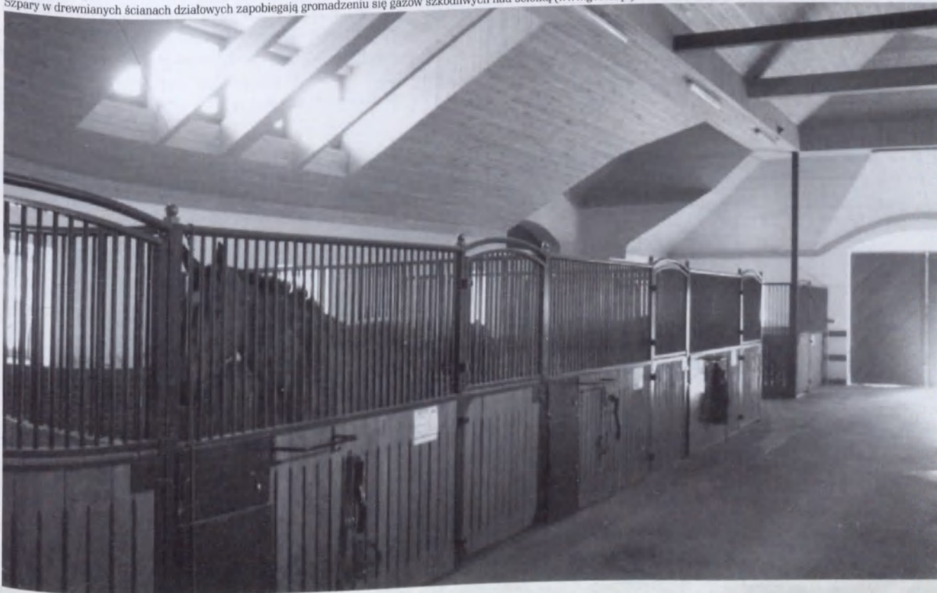
Szpary w drewnianych ścianach działowych zapobiegają gromadzeniu się gazów szkodliwych nad ściółką ( www.gostar.pl )
