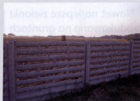
Fot. 1 Ogrodzenia żelbetonowe lub betonowe (zdjęcia: Piotr Stypiński)
