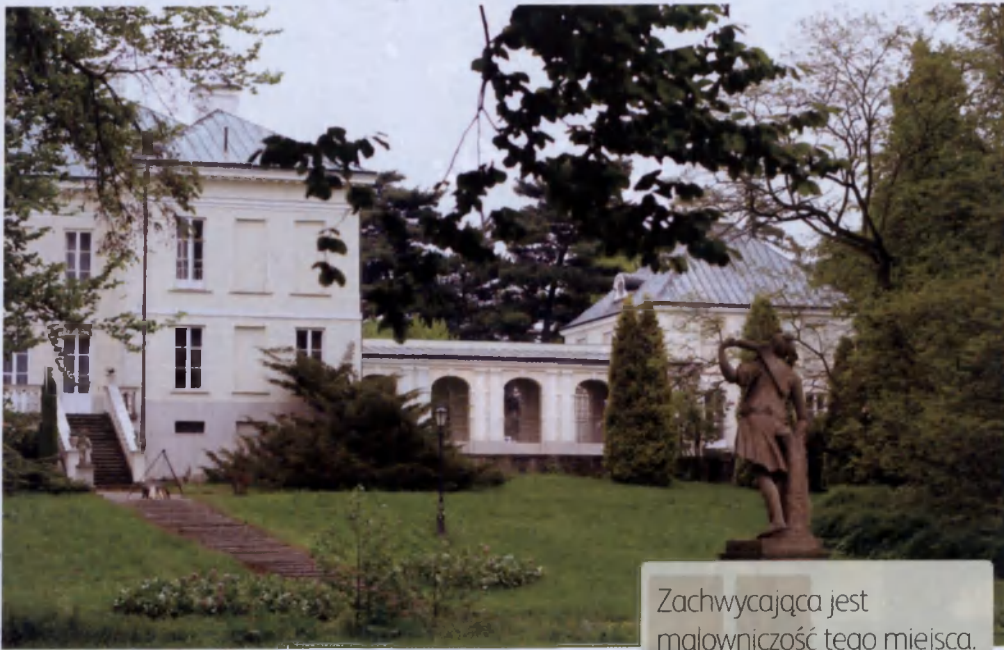
Fasada parkowa pałacu w SK Walewice.
