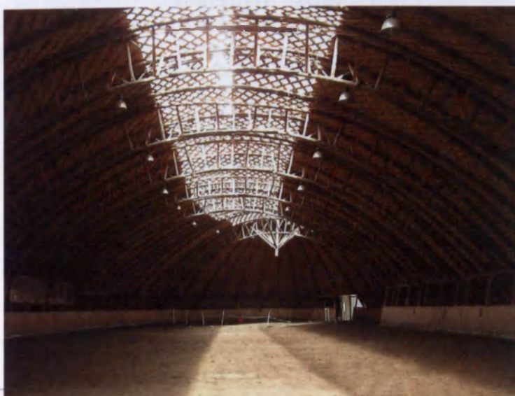
Niezwykle intrygująca konstrukcja krytej ujeżdżalni w Stajni Chojnów wykonana ze zbijanych drewnianych elementów kratowych
