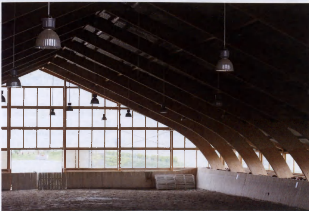
W Stajni Gostar do konstrukcji krytej ujeżdżalni użyto wiązarów z drewna klejonego – zestawienie ich z dużymi płaszczyznami szkła dało niezwykle efekt
