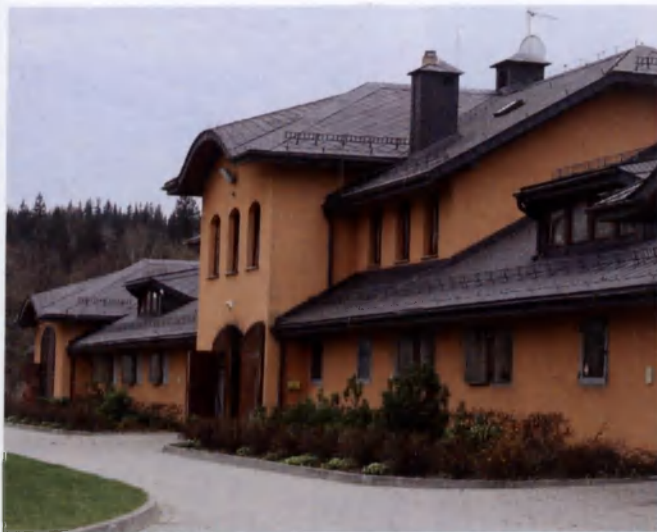
W stajni Gostar sięgnięto do tradycyjnego w okolicach sposobu krycia dachu łupkiem
