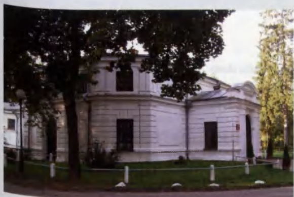
Silnie zaznaczone, proste gzymsy ożywiają strukturę ścian Stajni Czołowej w Janowie Podlaskim
