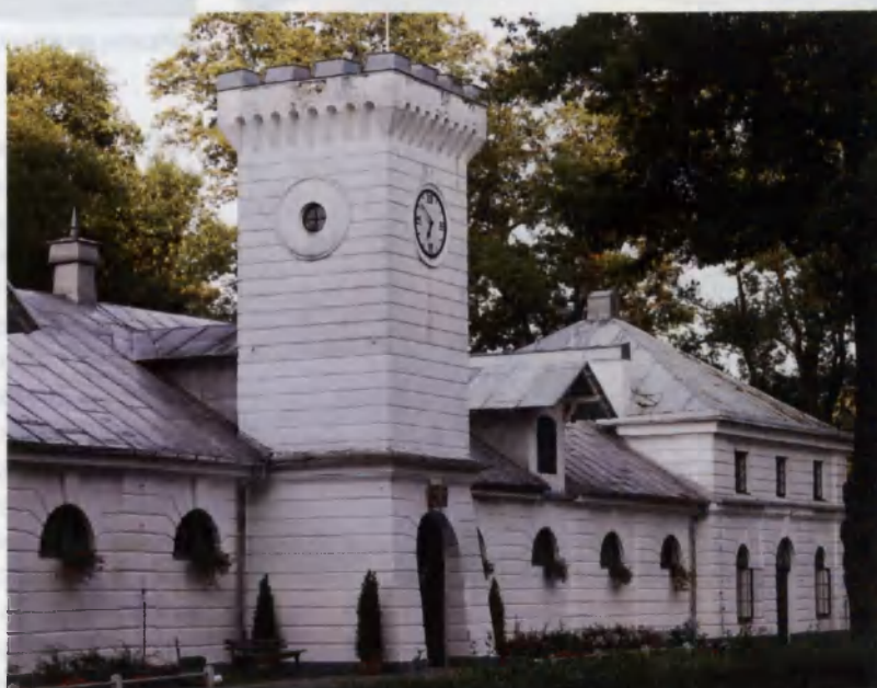
Zewnętrzna surowość Stajni Zegarowej w Janowie Podlaskim została zmiękczona przez zastosowanie miękkich linii półokrągłych okien i łuków wieńczących wejścia do budynku
