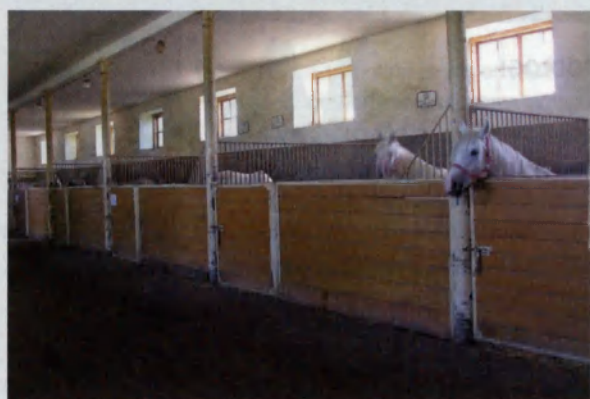
Podłoga korytarzowa betonowa w SO Białka
