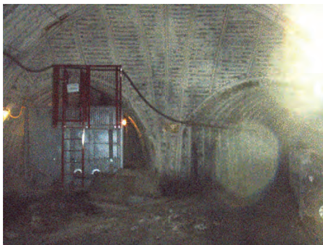
Fot. 2.2. Czoło odgałęzienia zabezpieczone obudową tradycyjną
