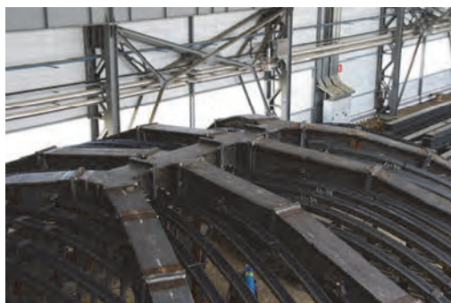
Fot. 6.14. Konstrukcja zmontowana próbnie u producenta
