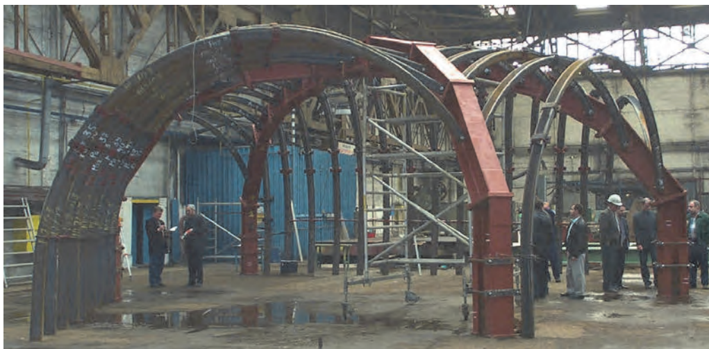
Fot. 4.4. Obudowa w trakcie montażu próbnego – widok od strony wyrobiska odgałęziającego się w prawo (rys. 4.5)
