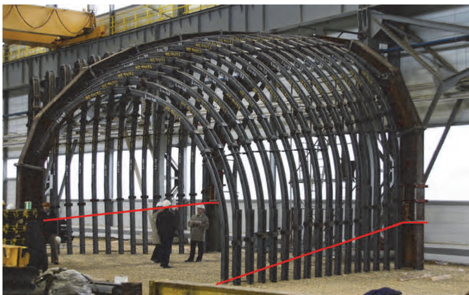
Fot. 6.7. Obudowa w trakcie próbnego montażu (czerwonymi liniami zaznaczono poziomy posadowienia obudowy w wyrobisku)
