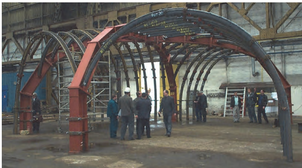
Fot. 4.5. Obudowa w trakcie montażu próbnego – widok od strony wyrobiska odgałęziającego się w lewo (rys. 4.5)
