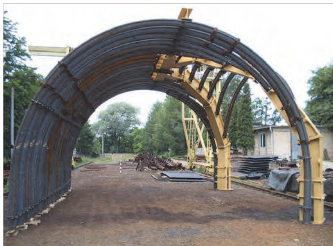
Fot. 6.3. Obudowa skrzyżowania w trakcie próbnego montażu u producenta
