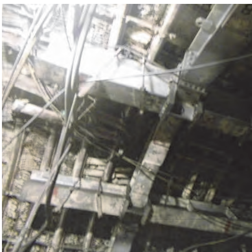
Fot. 6.18. Fragment konstrukcji wzmacniającej obudowę
