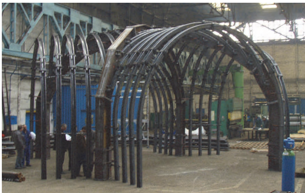
Fot. 6.4. Widok konstrukcji w trakcie montażu próbnego u producenta
