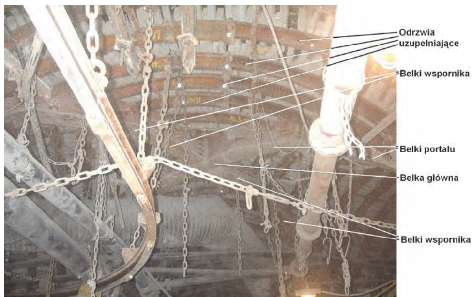
Fot. 6.5. Część przystopowa konstrukcji obudowy zabudowanej w wyrobisku
