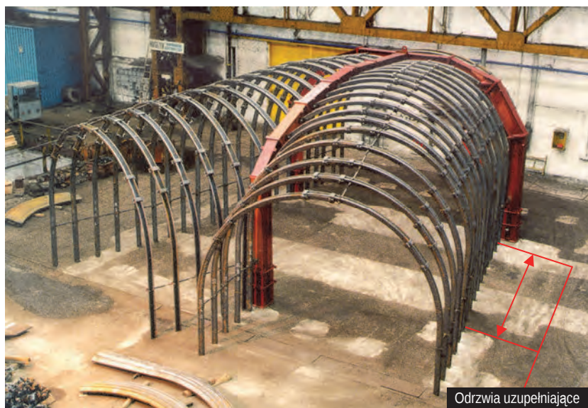
Fot. 4.6. Odrzwia uzupełniające w konstrukcji obudowy odgałęzienia
