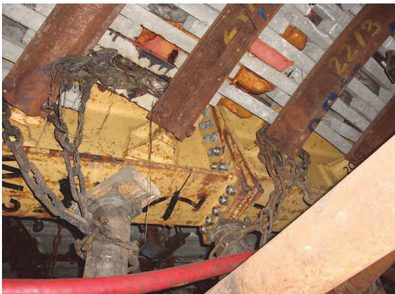
Fot. 5.4. Ogólny widok połączenia belek wspornika W2 i W3
