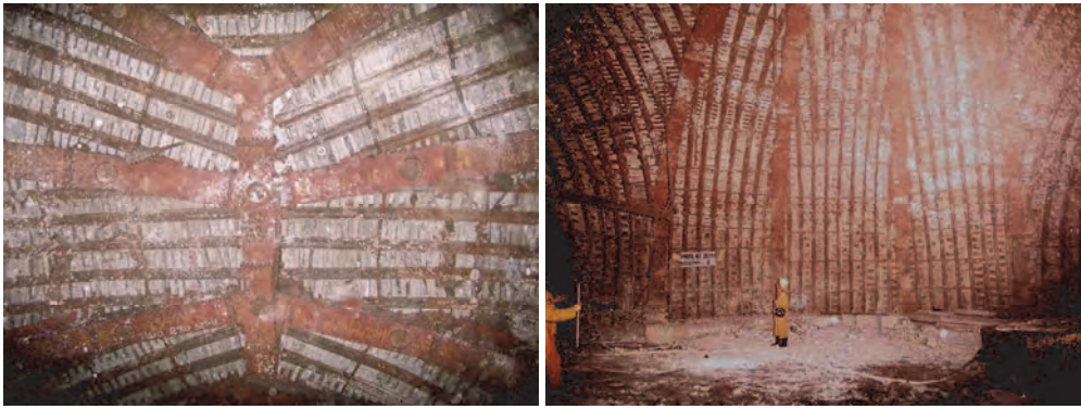
Fot. 6.15. Konstrukcja zmontowana w wyrobisku
