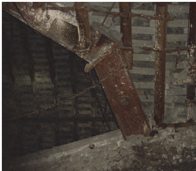
Fot. 6.8. Widok belek wspornika od strony pochylni odstawczej; widoczne wsporniki do posadowienia odrzwi uzupełniających
