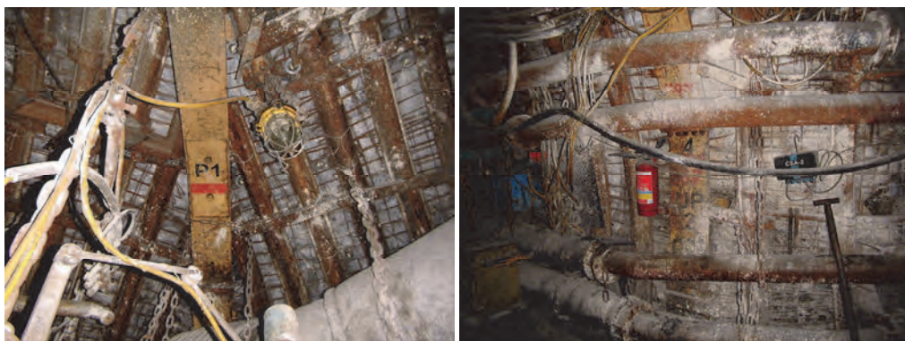
Fot. 6.17. Obudowa zabudowana w wyrobisku
