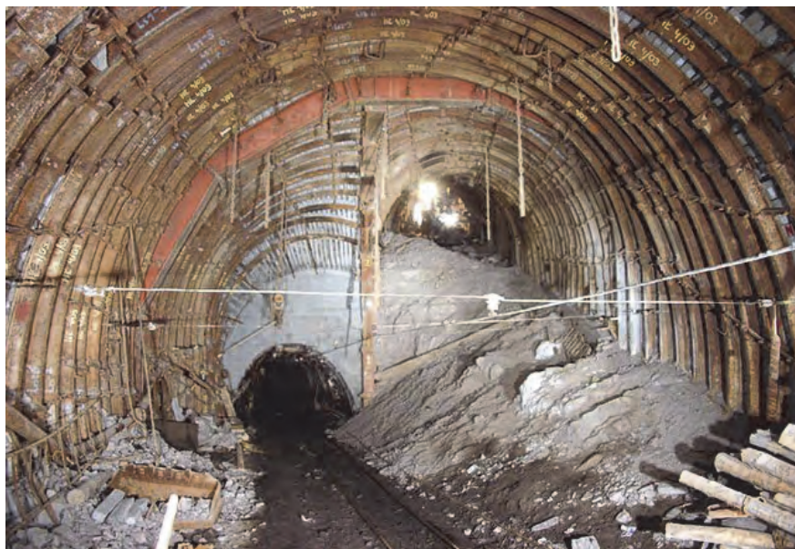
Fot. 6.9. Obudowa odgałęzienia w trakcie zabudowy (Internet 2)
