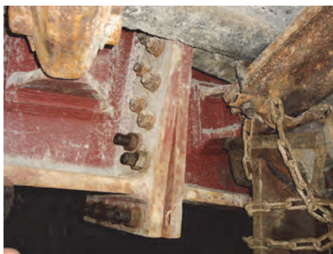
Fot. 5.3. Nowe śruby i nakrętki w połączeniu belek W2 i W3
