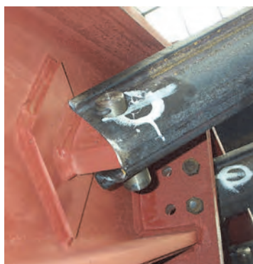
Fot. 4.1. Łącznik jednoprzegubowy
