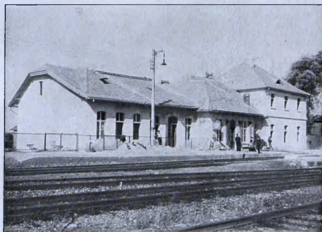
Stacja Makoszowy D. K. P. Katowice (nowo wybudowana).
