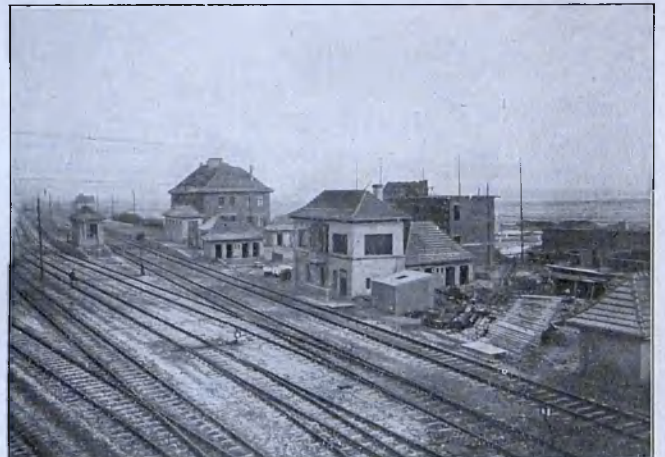
Stacja Brzeziny Śląskie D. K. P. Katowice (nowo wybudowana).
