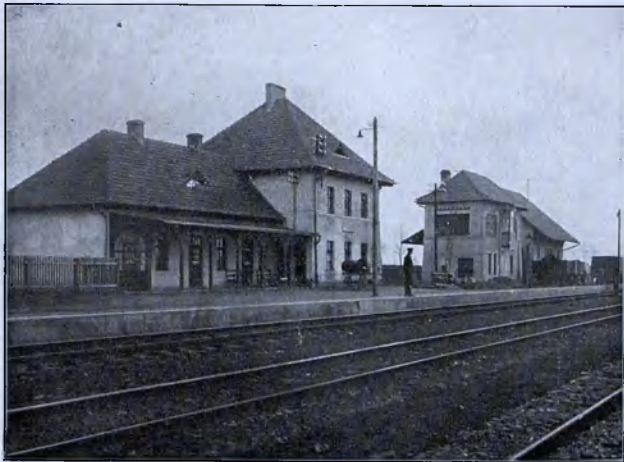
Nowo wybudowana stacja Strumień D. K. P. Katowice.
