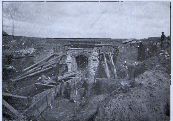
Przebudowa tunelu na linii Chorzów—Szarlej D. K. P. Katowice.
