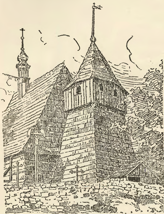
Rys. 154. Kościół w Mikuliczynie (Mikultschütz) na Śląsku — Wieża ma zadaszenie ośmioboczne nad kwadratem o krawędziach w osiach. (do rys. 168).
