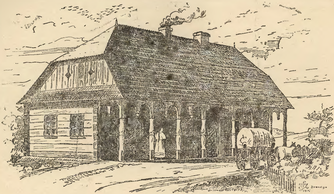
Rys. 136. Karczma polska z podcieniem o mieczach w „cietno” zestawionych na zasadzie słupka wiszącego czyli wieszara pomiędzy słupami.
