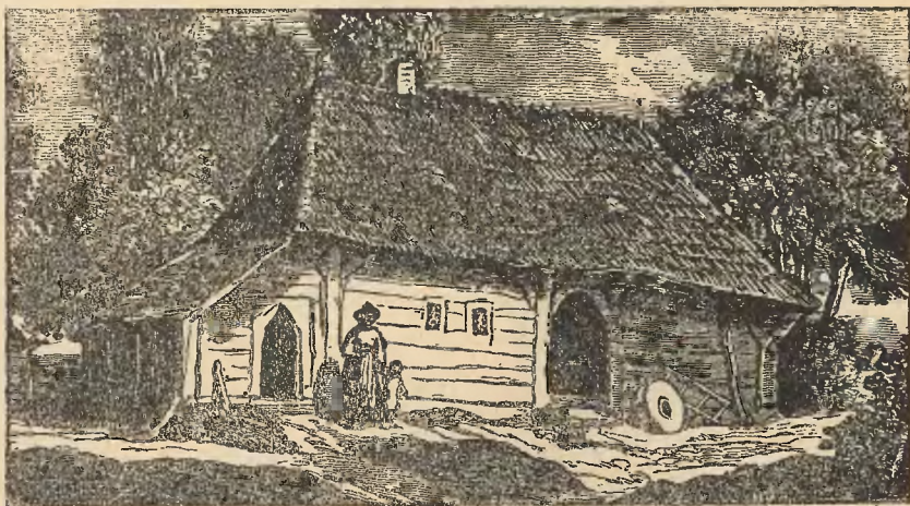
Rys. 24. Młyn skrobacz w Modlnicy koło Krakowa, ze słupami przy ścianach wieńcowych, co stanowi tak zwany „przyłap“ (Wedle Kolberga).
