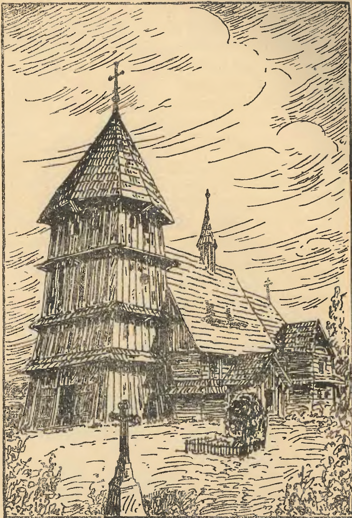
Rys. 14. Wieża w Dzierżgowicach z zadaszeniem w taki sposób założonem, że krawędzie ośmioboku wpadają na osie. (Rys. arch. Fiala).
