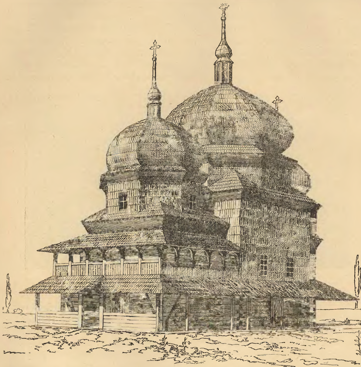
Rys. 207. Cerkiew w Rozdole. Podcienia piętrowe. Trzy kopuły odpowiadają trzem częściom rzutu poziomego. (Do rys. 218).
