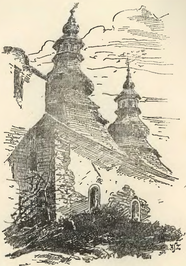
Rys. 157. Widok kopuł nad nawą i częścią kapłańską. Założenie w ośmioboku o krawędziach po przekątnej.
