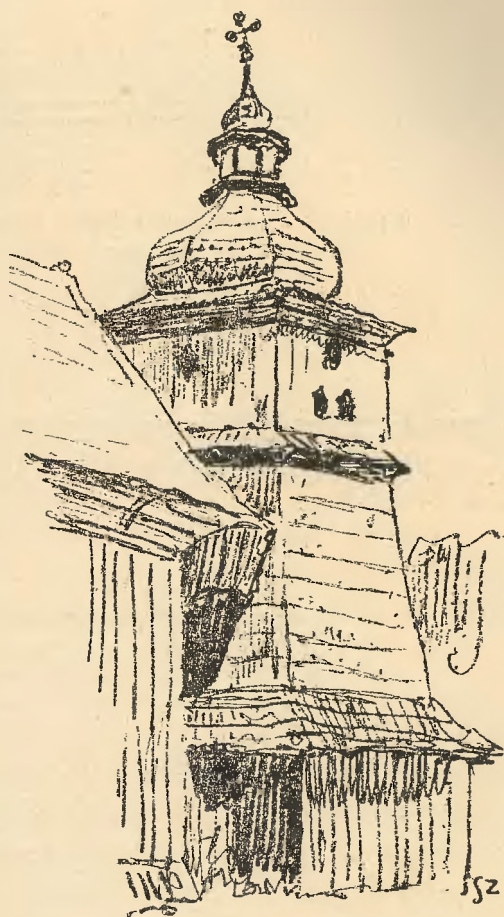
Rys. 69. Wieża kościoła w Barwałcie, z kopułą o krawędziach po osiach głównych i przekątniowych.
