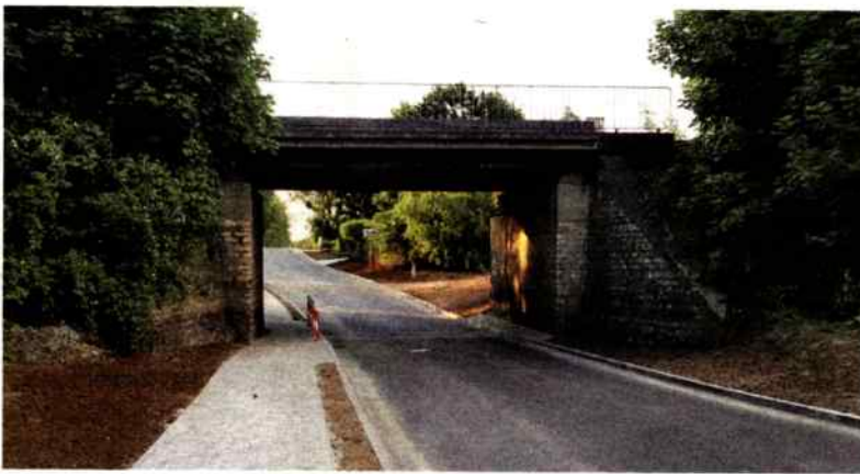
Wiadukt w Rogach udało się pogłębić o pół metra
