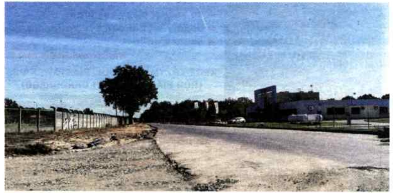
Przebudowa trzykilometrowego odcinka łączącego Bierawę z Korzonkiem to koszt prawie 14 mln zł
