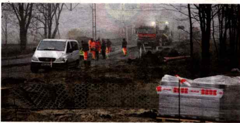
Prace idą pełną parą
