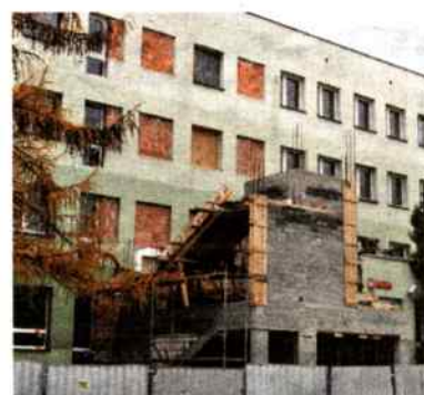
Dobiega końca budowa internatu
