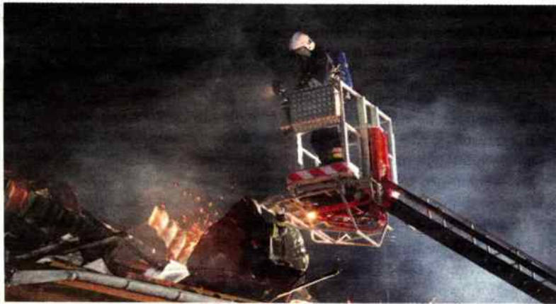
Strażacy w nocy usuwali niebezpieczne elementy z dachu
