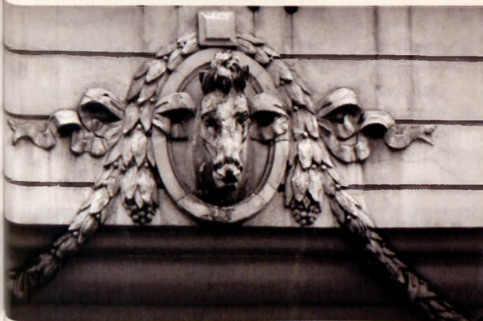
▲ Ostatni ślad istnienia krytej ujeżdżalni na ulicy Litewskiej w Warszawie
