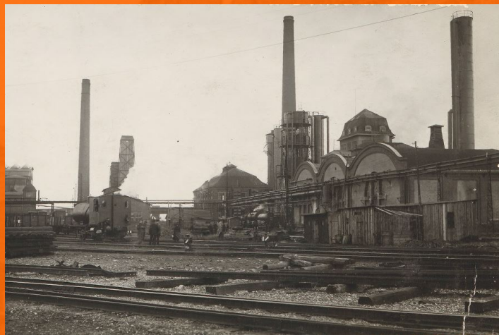
Koksownia w Gliwicach, przed 1939 r.
