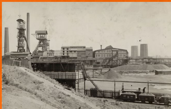
Kopalnia Centrum, 1935-1942 r.
