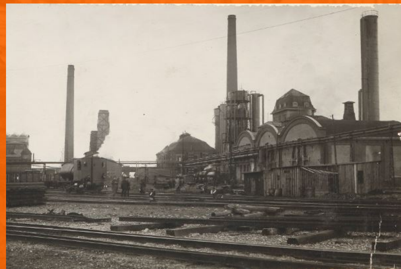
Koksownia w Gliwicach, przed 1939 r.
