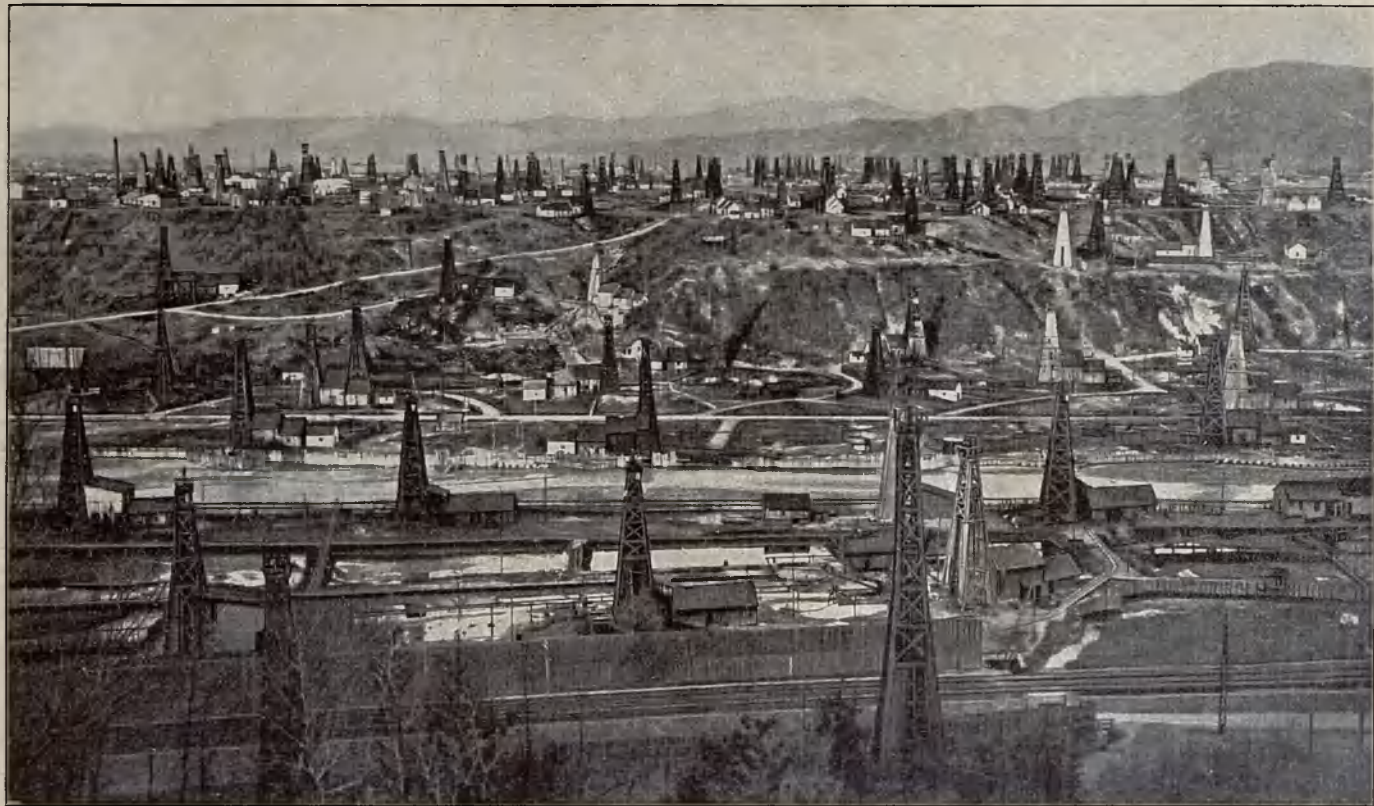
52. Petroleumfelder bei Kämpina. Der Außenrand der Karpaten weist zahlreiche Petroleumfelder auf. In Rumänien erlangten die Fundstellen von Kämpina, Ploescht, Buzau u. a. besondere Bedeutung, da sie die ergiebigsten in Europa sind. In Bohrlöchern wird das wertvolle Erdöl gewonnen, große Rohrleitungen leiten es in sogenannte Öltanks, wo es gesammelt wird. Von hier aus erfolgt der Abtransport auf dem Wasserwege in Tankschiffen oder auf dem Landwege in Tankwagen. Die rumänische Tagesförderung von Petroleum im Jahre 1914 betrug 489 Waggon.
