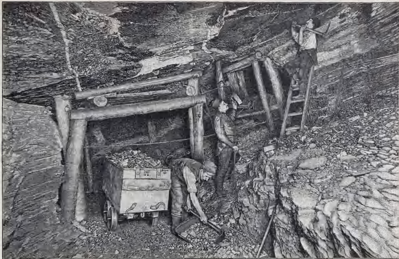
Im Innern eines Kohlenbergwerks. (Abbaubetrieb: Die Hauer beginnen den Auschieb des letzten über der Abbaustrecke anstehenden Kohlenpfeilers; im Hintergrunde wird der Bremsberg sichtbar.)
