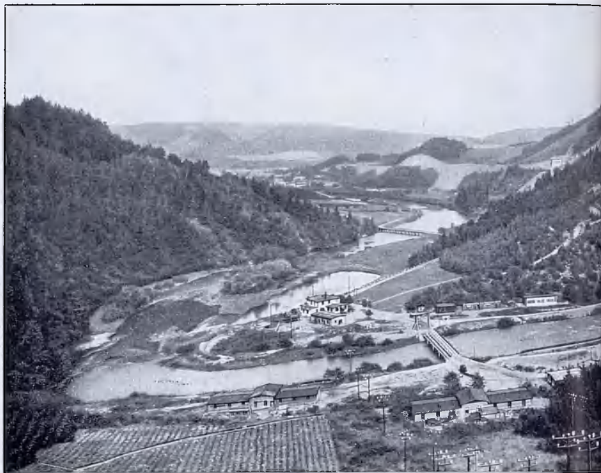
11. Die Bobertalsperre Die Bobertschleife unterhalb der Sperre. Rechts die Mündung des Umlaufstollens, die Sperrmauer
