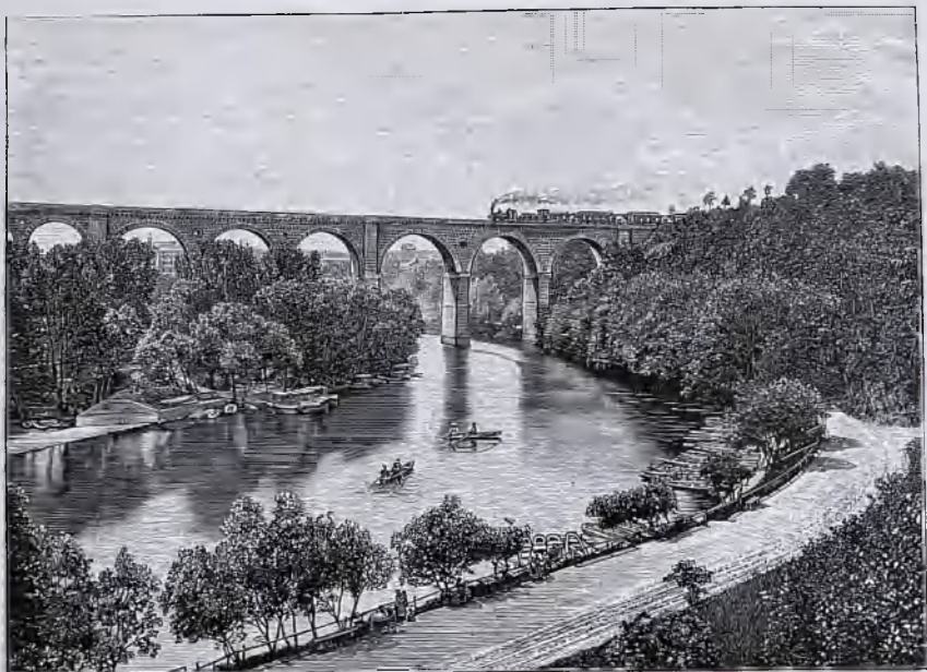
24. Der Eisenbahnviadukt über die Neiße bei Görlitz.
