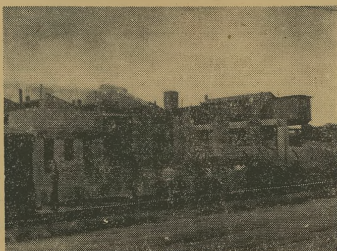
W akcji polepszania higienicznych i zdrowotnych warunków pracy w Zakładach Górniczo-Hutniczych Orzeł Biały w Brzezinach, buduje się obszerną i doskonale wyposażoną łaźnię. Na zdjęciu aktualny widok budowy.
