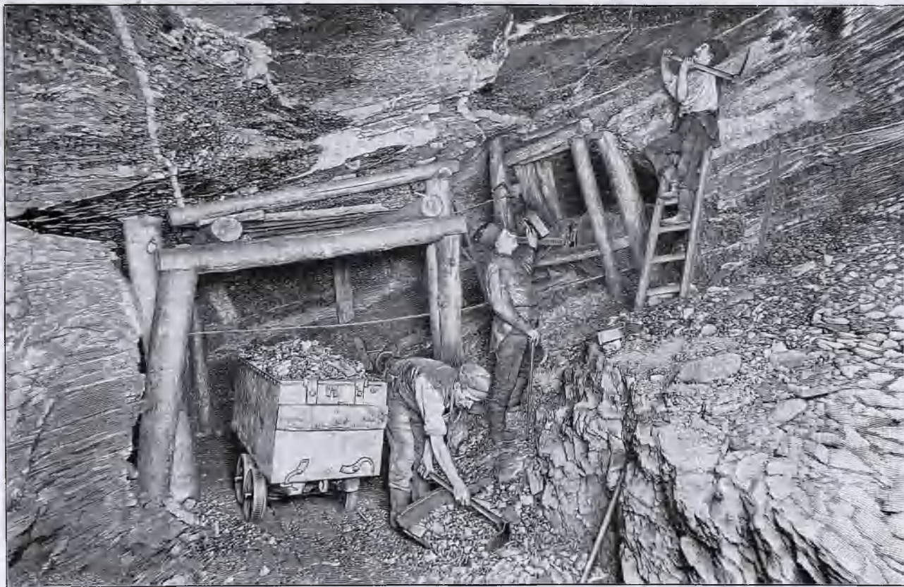
Im Innern eines Kohlenbergwerks. (Abbaubetrieb: Die Häuer beginnen den Auschieb des Letzten über der Abbaustrecke anstehenden Kohlenpfeilers; im Hintergrunde wird der Bremsberg sichtbar.)
