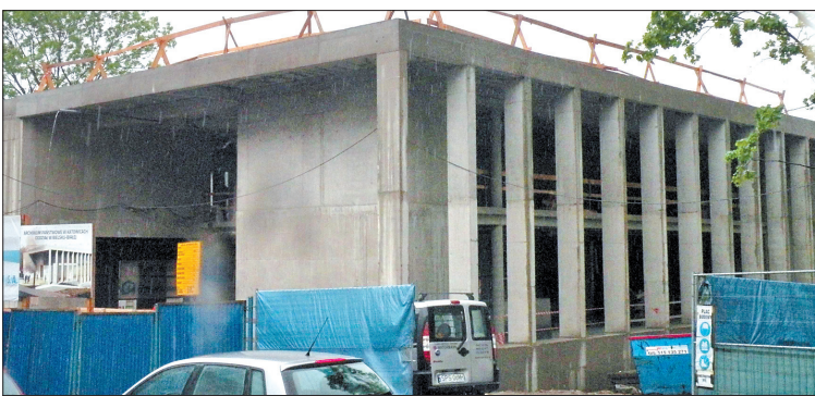
Gmach Archiwum Państwowego w budowie.
