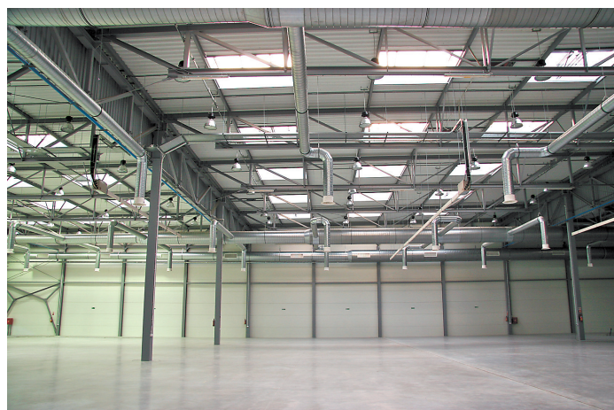
Wnętrze jednej z zaprojektowanych i zrealizowanych przez DS-T hal produkcyjnych w Katowickiej Specjalnej Strefie Ekonomicznej.
