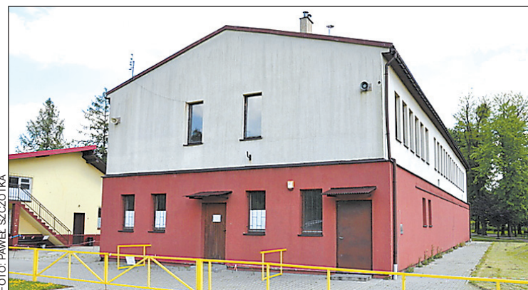
Sala sportowa w Malcu zamknięta jest od kilku miesięcy z powodu złego stanu technicznego.
