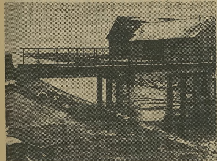
Na brzegu Liswarty trwają prace regulacyjne (z lewej). Kierownik budowy zbiornika Zielona (z prawej) — JOACHIM KOŁODZIEJ z dumą pokazuje rozległy teren budowy.
