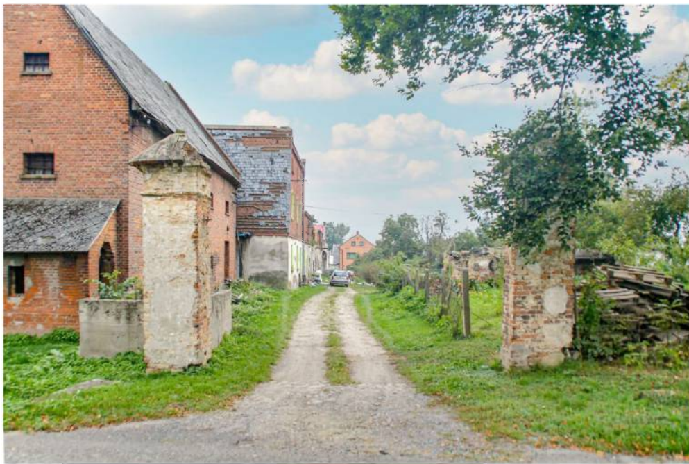
GADZOWICE. BRAMA WJAZDOWA / © FOT. M. KITKA
