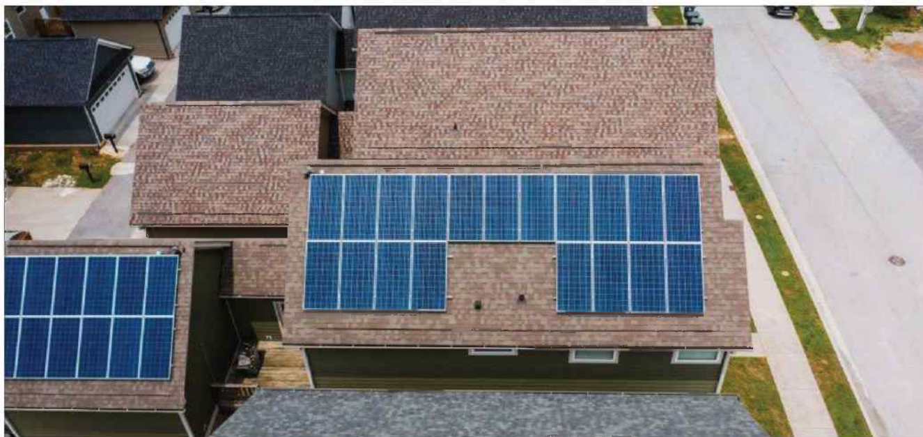
Zwolnieniu z podatku od nieruchomości m.in. w Rybniku i Wodzisławiu Śląskim podlegają budynki, w których wymieniono kopciuchy na ekologiczne źródło ciepła, np. pompę ciepła, ogrzewanie gazowe, podłączenie do sieci ciepłowniczej czy ogrzewanie elektryczne – np. z fotowoltaiki (na zdj.).
