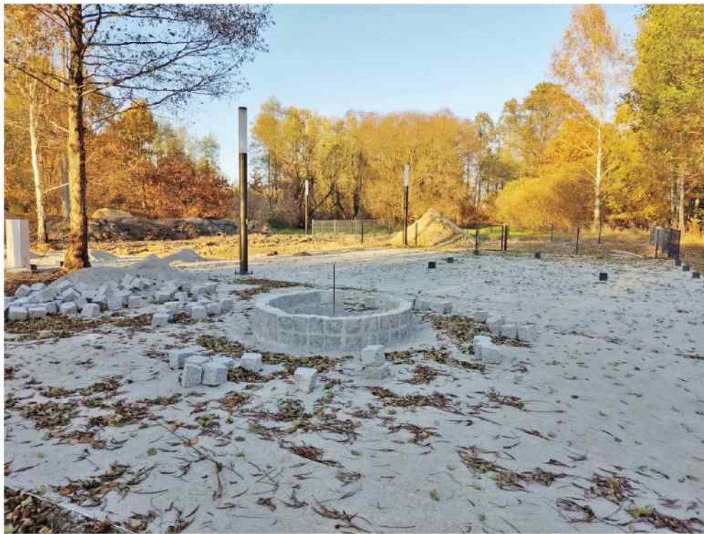
W ostatnim czasie na placu budowy wykonano m.in. latarnie i miejsce na grilla
