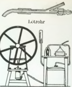
Schlörings Lötrohr mit Blasebalg
