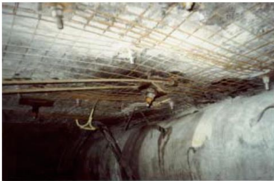
Fot. 3.3. Obudowa kotwowo-ciężnowa z linami stalowymi przed nadaniem jej naciągu wstępnego [95]
