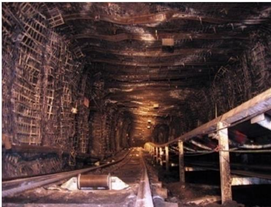
Fot. 3.6. Wrobisko wykonane w samodzielnej obudowie kotwowej w irańskiej kopalni Tabas [122]
