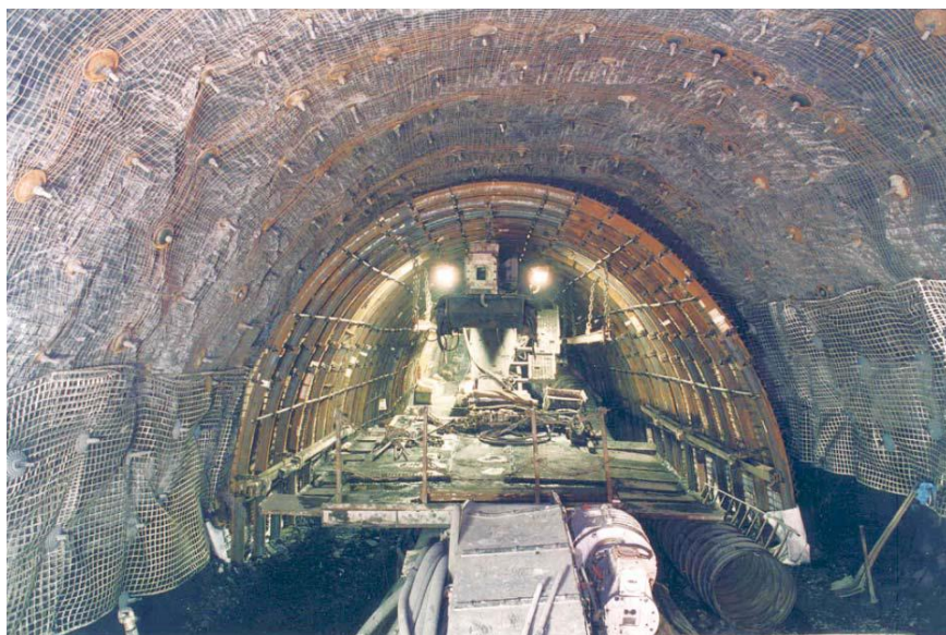
Fot. 3.1. Widok chodnika wykonanego w obudowie mieszanej typu A [64]
