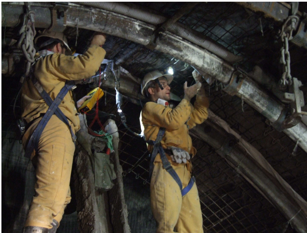
Rys.8. Badania materiału na obudowie łukowej [źródło: fotografia KOMAG]
