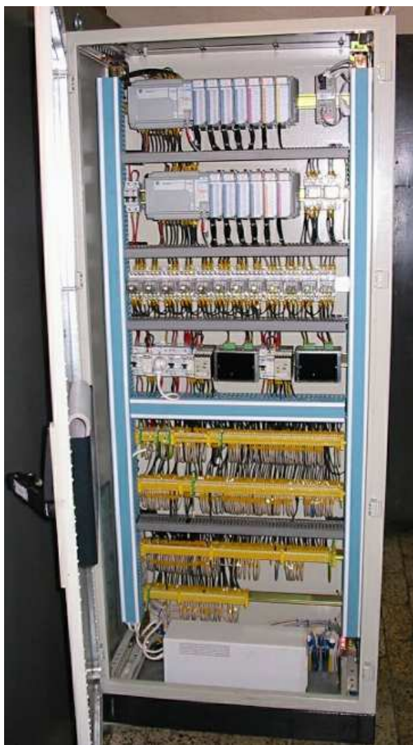
Rys.1. Elektropneumatyczny zespół sterowania hamulców typu ZSHP – elementy składowe
