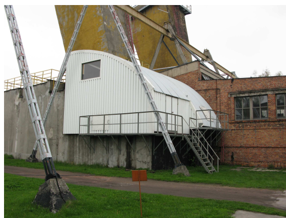
Rys.11. Obudowa dźwiękochłonna-izolacyjna zaprojektowana przez KOMAG w ramach zadania wyłumienia wentylatora wyciągowego [5] (model geometryczny obudowy, układ wentylatora przed zabudową obudowy i po jej zabudowie)
