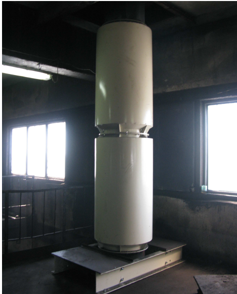
Rys.4. Tłumiki typu TG, do stosowania w atmosferze zagrożenia wybuchem metanu i pyłu węglowego [4, 5]: a) tłumik TG 630/2000, b) typoszereg tłumików TG z elementem rozpraszającym
