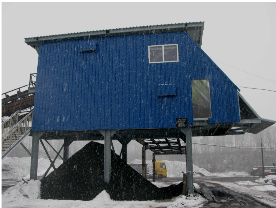
Rys.12. Zabudowa stacji załadunkowej węgla ograniczająca emisję dźwięku z przesiewacza wibracyjnego [12]
