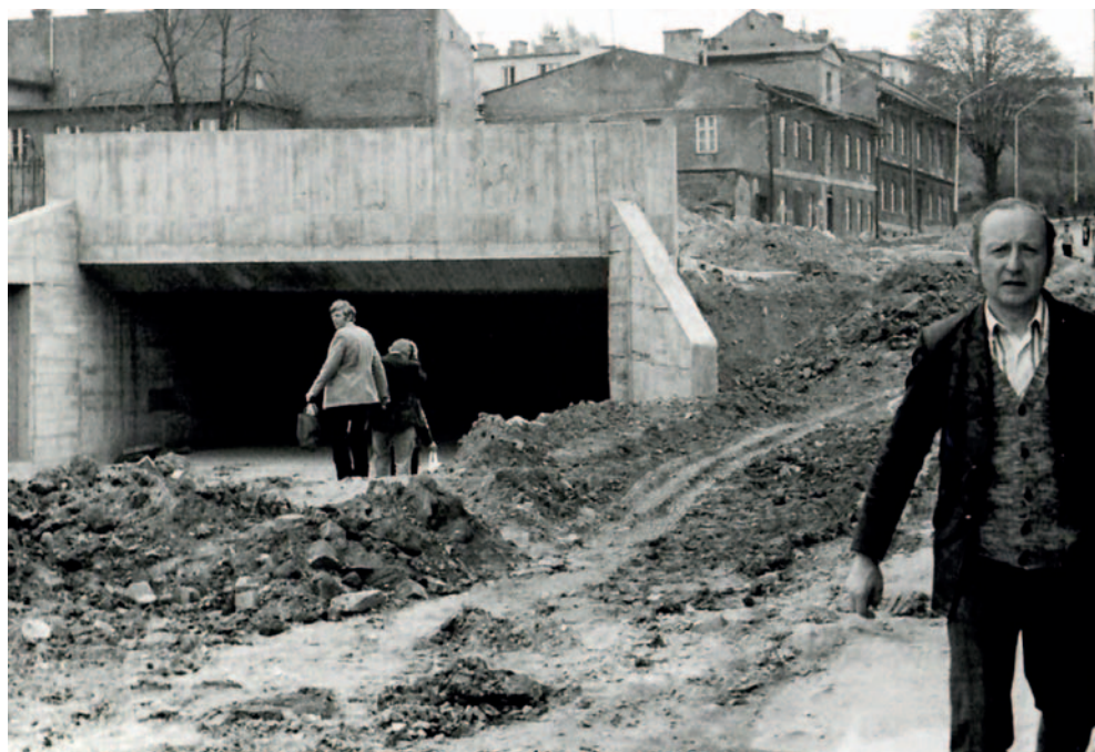
Budowa przejścia podziemnego pod dzisiejszą ulicą Lwowską
