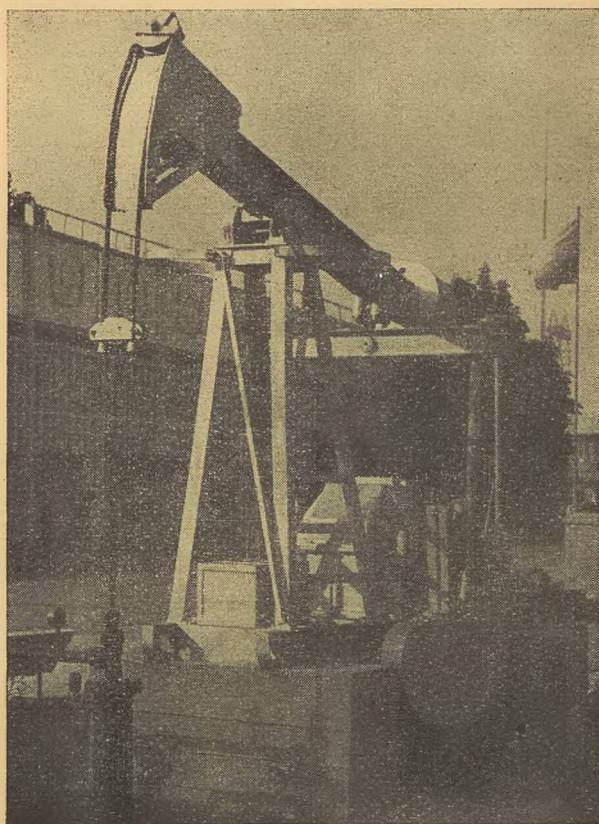
Rys. 8. Urządzenie do pompowania ropy z odwiertów, tzw. „konik”
