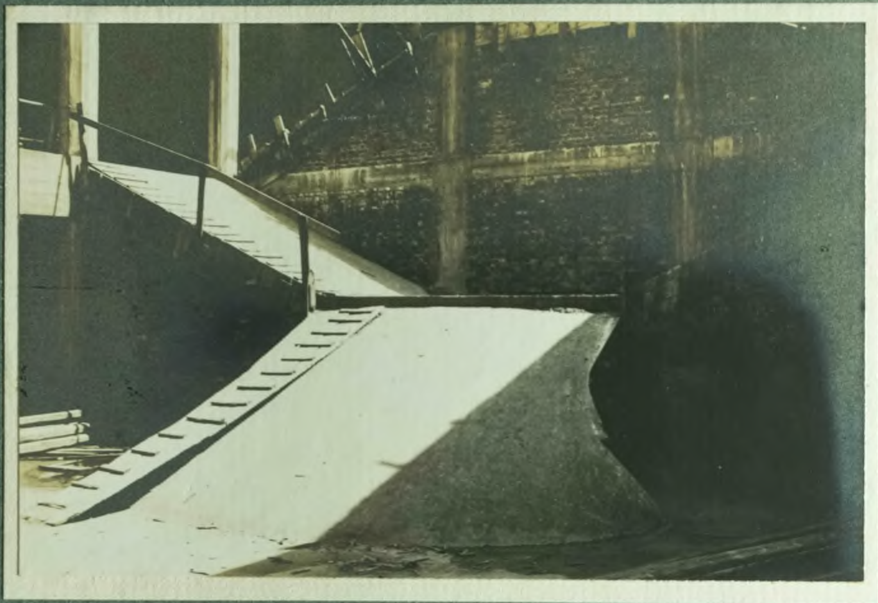
Żelbetowe płyty pod schody w głównym westibulu (czerwiec 1926 r.).
