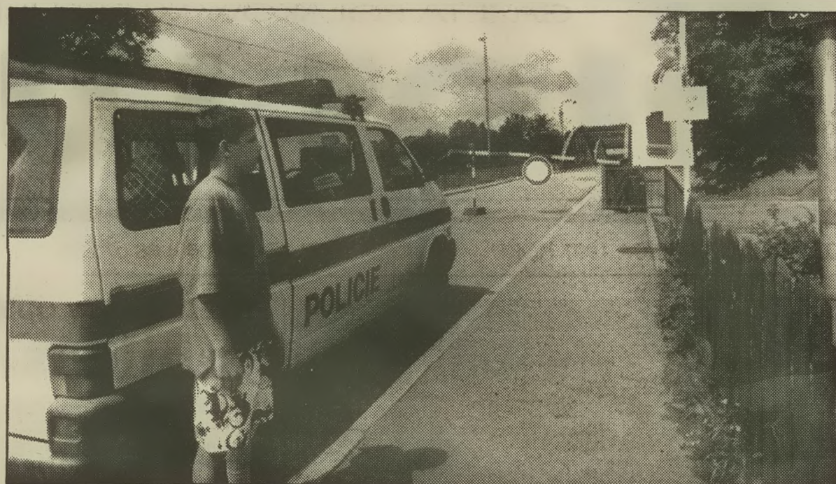
▲ Niedawną powódź przypomina także znak drogowy „Zakaz wjazdu” na moście granicznym w Boguminie-Chałupkach, który musiał zostać zamknięty wskutek uszkodzenia jednego z przęseł.
