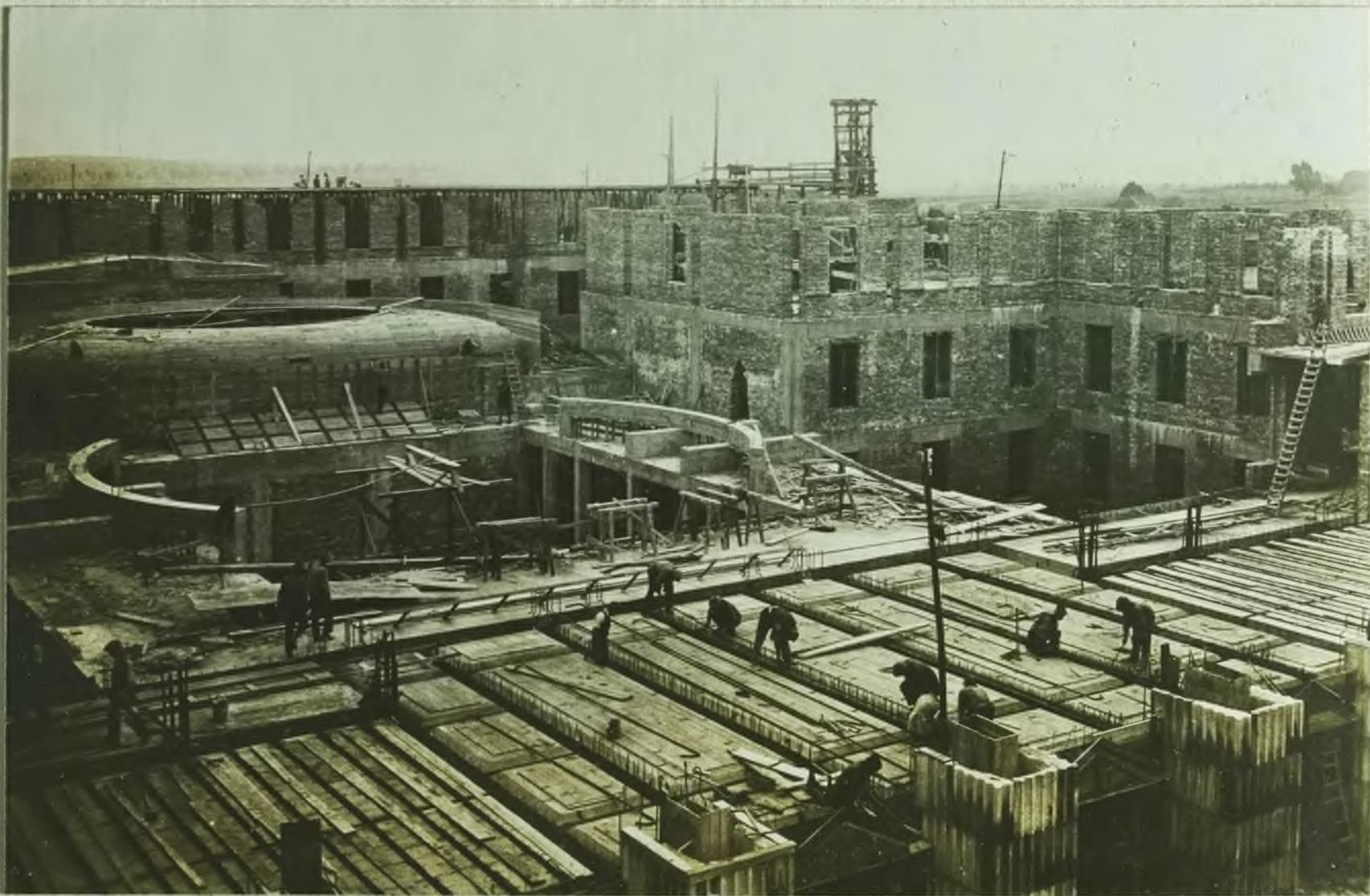
Zbrojenie stropu kasetonowego żelbetowego nad salą recepcyjną oraz filarów od Nowego Placu (sierpień 1926 r.).
