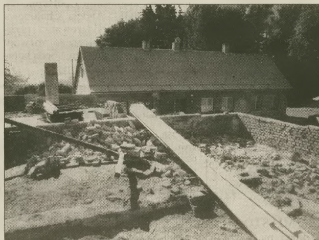
▲ Prace remontowe podczas przeróbki.
