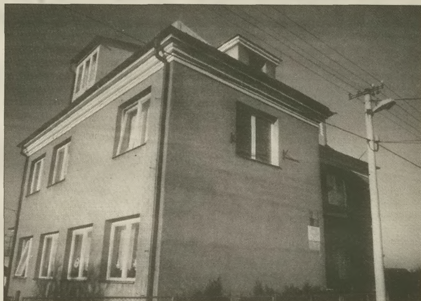
◀ Wanda Heller słowami pełnymi miłości mówi o swoich wychowankach i szkole. ▲ Budynek szkoły w Orłowej-Lutyni.
