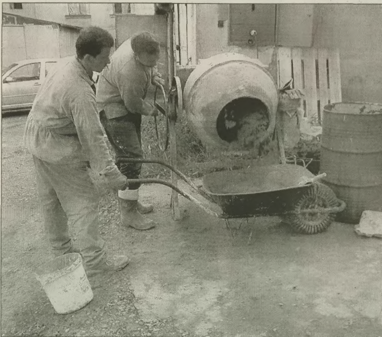
▲ W siedzibie Kongresu Polaków w RC przebiegały wczoraj prace przy odnowie korytarza. Na zdjęciu pracownicy firmy Holub przygotowują beton pod nową posadzkę i przy pomocy siatki metalowej wzmacniają jej konstrukcję. Fot. MAREK SANTARIUS
