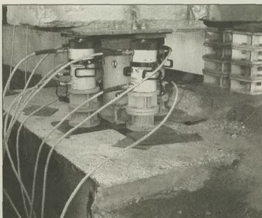
▲ Hydrauliczne podnośniki pod konstrukcją mostu. Fot. MAREK SANTARIUS
