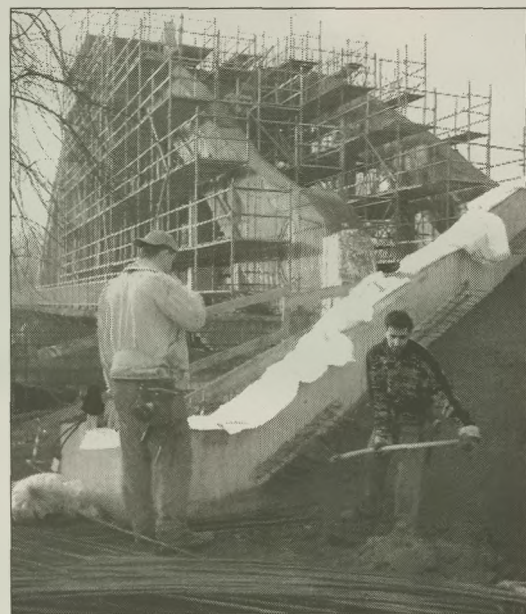
▲ Budowa schodów dla pieszych Fot. MAREK SANTARIUS
