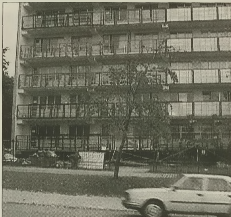
◀ Kilkadziesiąt milionów z kasy miejskiej wydano w tym roku w Karwinie na remont i modernizację mieszkań oraz domów w posiadaniu miasta. Latem w kilku frysztackich i nowomiejskich budynkach wymieniano dachy i okna, teraz kolej na wymianę balkonów w jednym z domów w Karwinie Granicach. Fot. WANDA KULA
