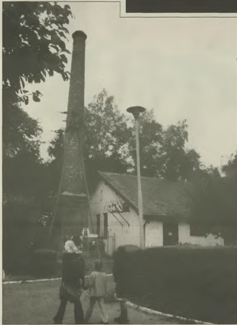
▲ Obok latarni do dziś stoi elektrownia parowa z kompletnym wyposażeniem. Maszyny w idealnym porządku oczekują aż wybije ich czas. Awaria prądu nie zaskoczy tu nikogo. Zdjęcia: MARTYNA RADEWSKA-OBUSNIK
