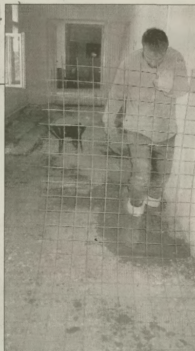
▲ W siedzibie Kongresu Polaków w RC przebiegały wczoraj prace przy odnowie korytarza. Na zdjęciu pracownicy firmy Holub przygotowują beton pod nową posadzkę i przy pomocy siatki metalowej wzmacniają jej konstrukcję. Fot. MAREK SANTARIUS
