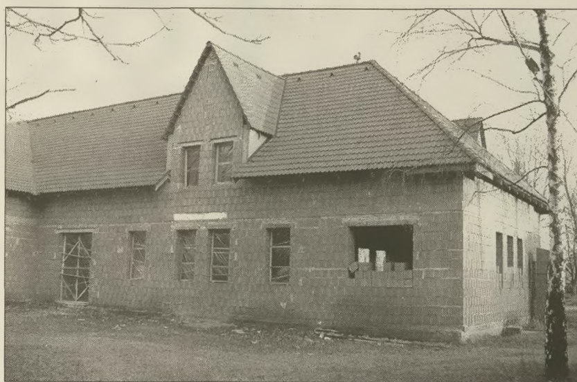
▲ W takim stanie budynek zaimmowano. W najbliższym czasie wstawione zostaną okna i ruszą wewnętrzne prace wykończeniowe.
