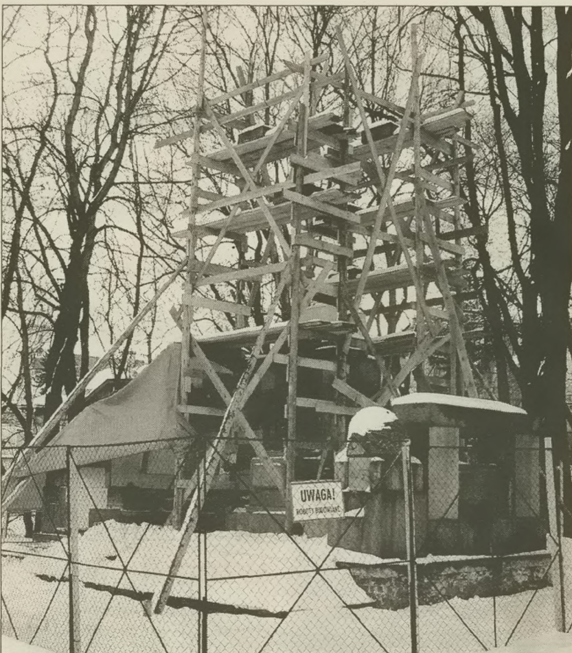
Prace przygotowawcze do renowacji pomnika Mieszka w Cieszynie rozpoczęto już jesienią, na dobrą sprawę ruszyły jednak dopiero w ubiegły poniedziałek. Prace konserwatorskie powinny być zakończone pod koniec kwietnia lub na początku maja.
